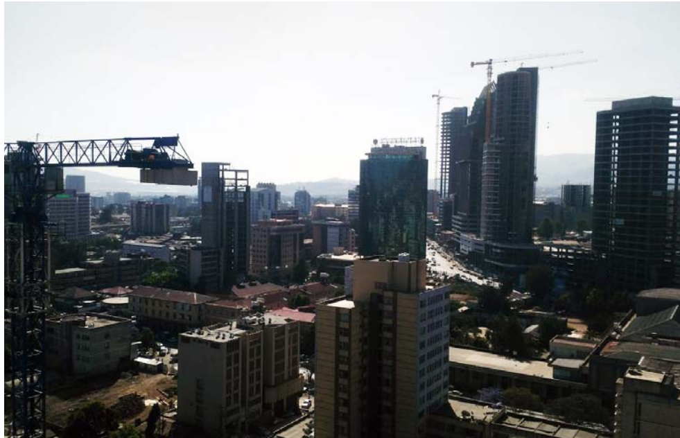
Quartier des affaires en construction à Mexico, centre-ville.
