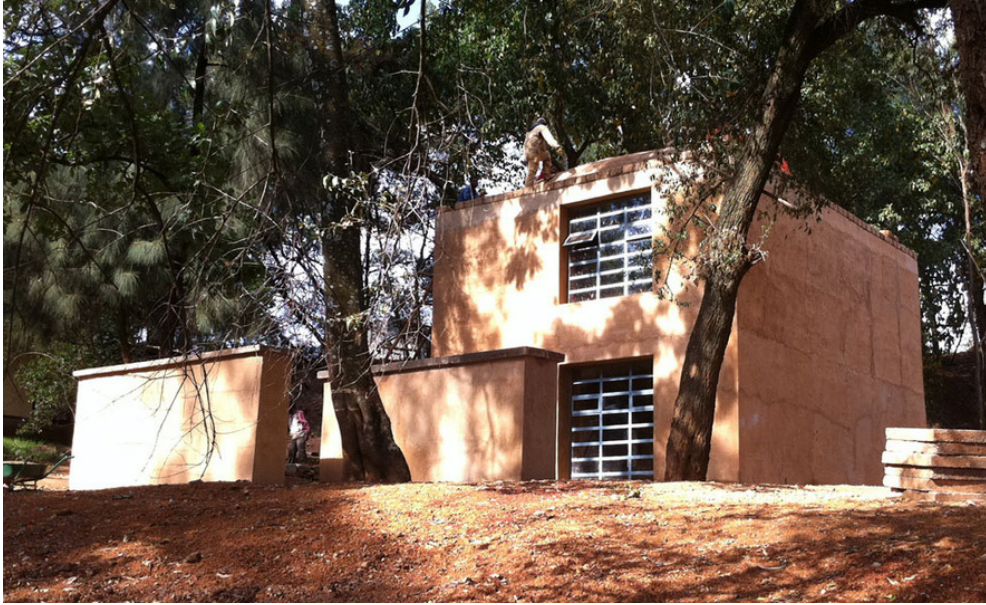
Bâtiment expérimental SUDU sur le campus de l'EiABC. Photo de ETH Zurich.
