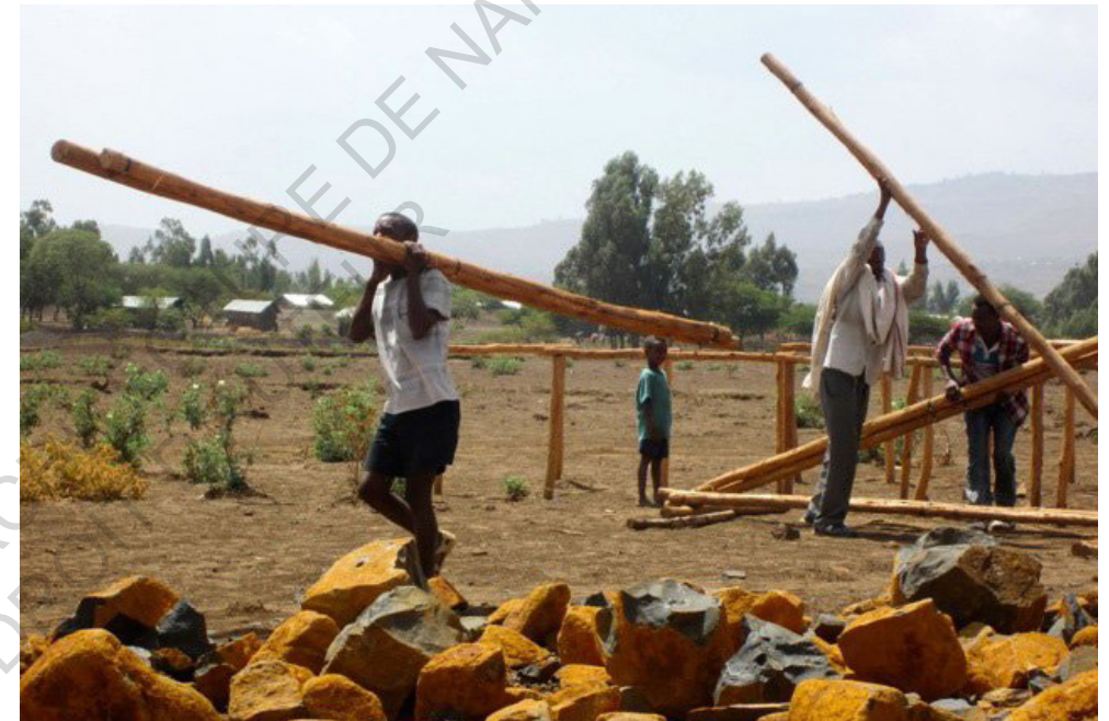
NESTown Project. Bura, Amhara. Les habitants commencent le chantier. Photo de l'ETH Zurich.
