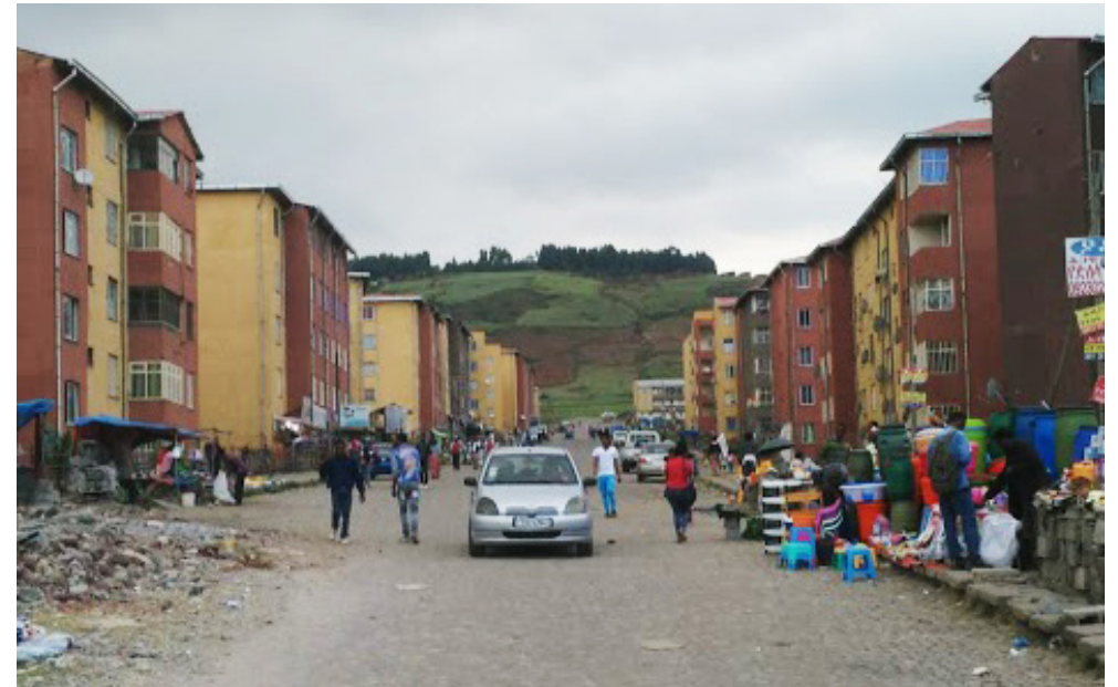
Quartier de condominiums à Yeka Abado, périphérie est de la ville.
