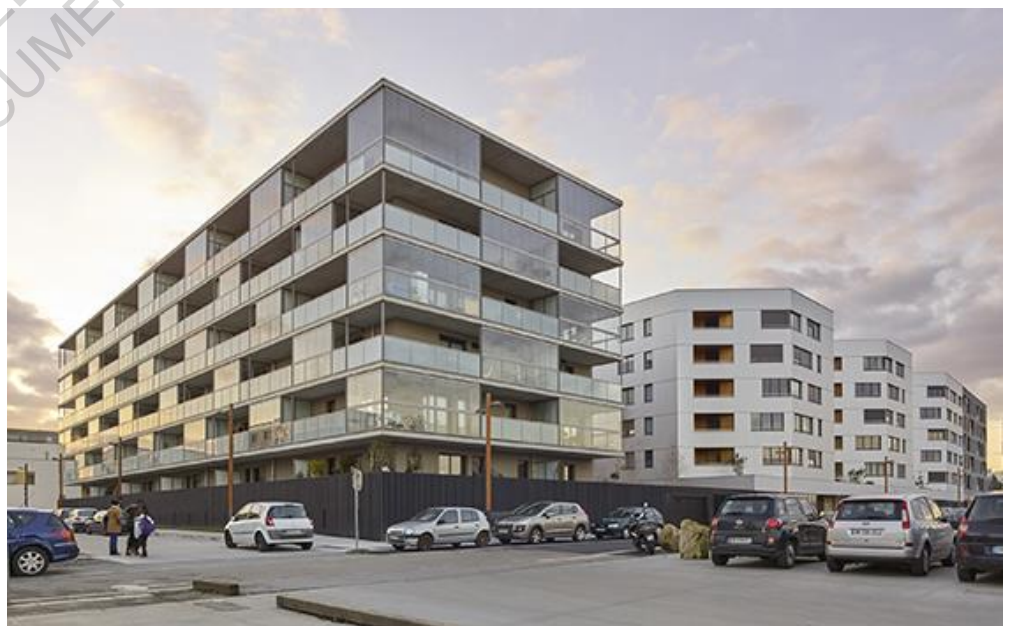
Figures 25 et 26: Photos des stationnements et logements collectifs, 2014, ©DLW Architectes
