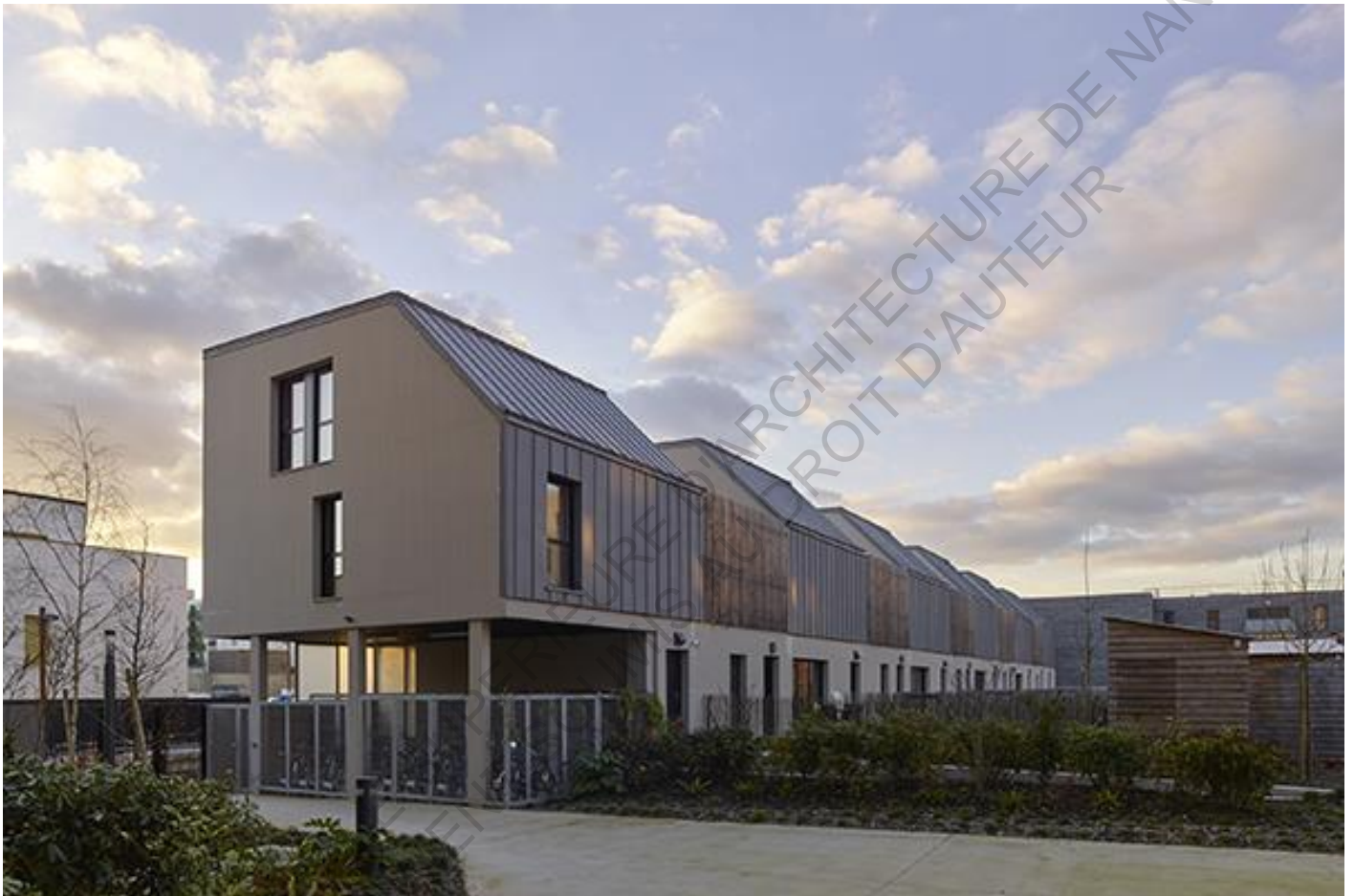
Figure 24: Photo du local à vélo et des logements intermédiaires, 2014, ©DLW Architectes
