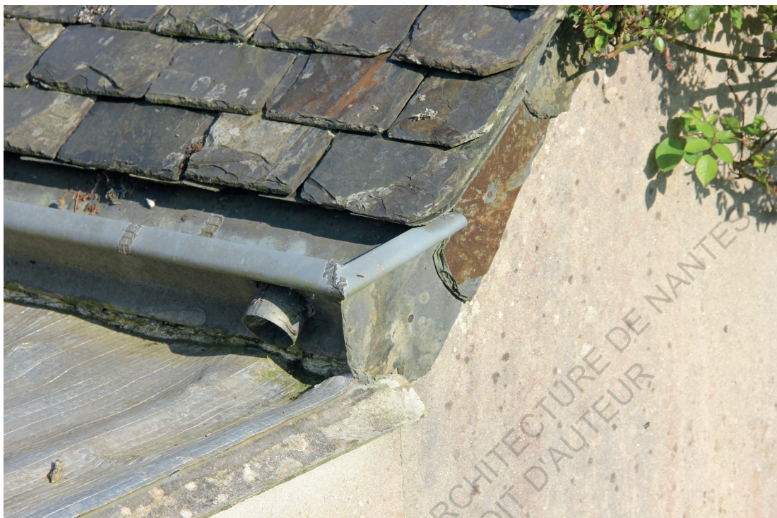
^ Détail du toit en tuile de la chaumière, Kervoëlic, le 26 Avril 2020
