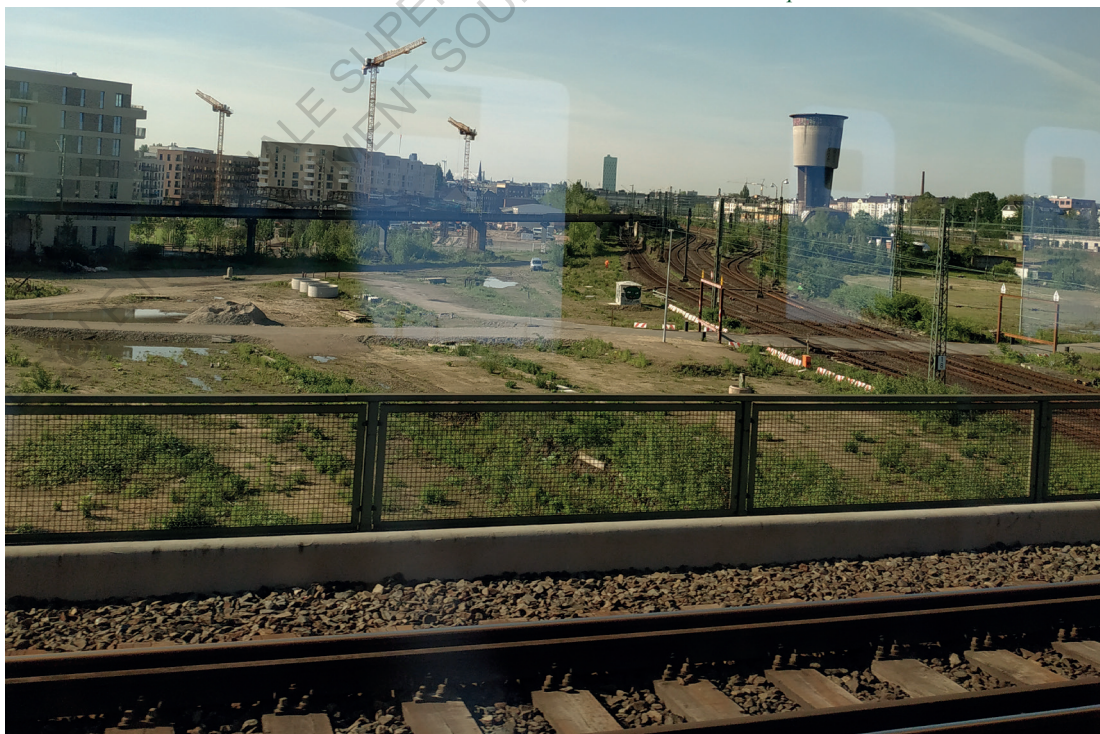
Vue sur les chantiers d'Altona depuis le S-Bahn le 23 Mai 2019 v
