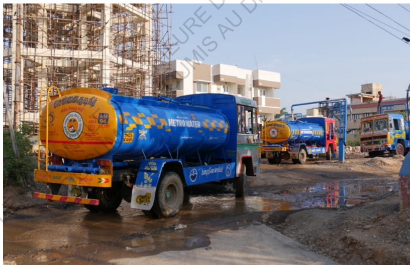
Fig. 11 : Camion-citerne à la station de remplissage. L'eau provient des usines de désalinisation.
