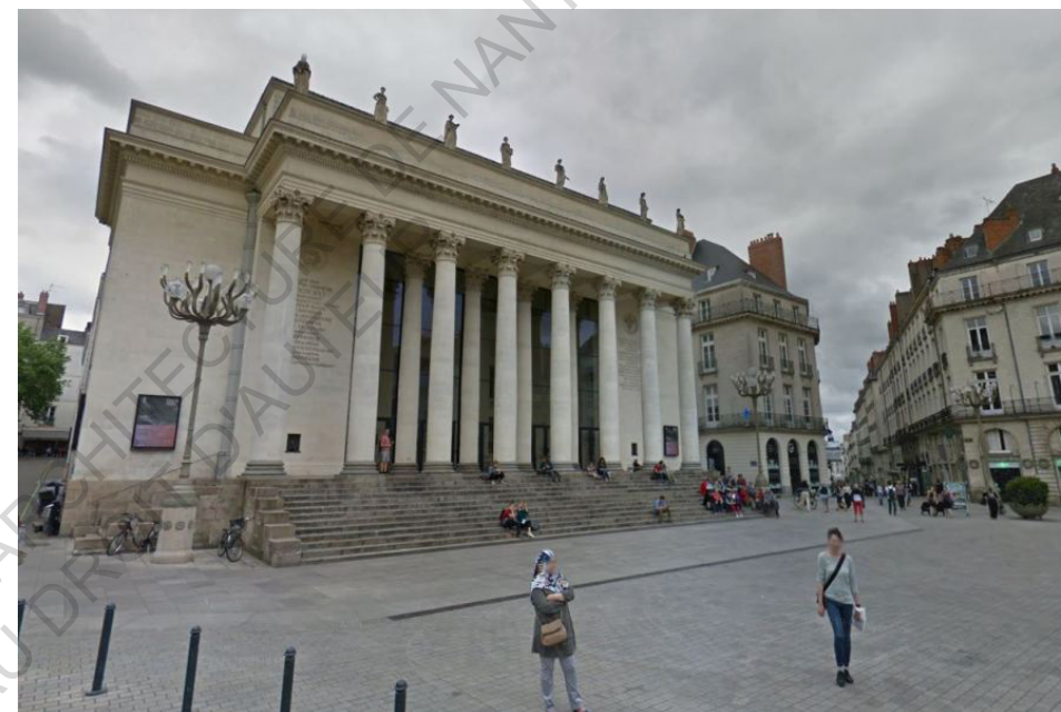
▲ Photographie de la place Graslin. Sur cette photographie, on peut clairement voir la ligne d'évacuation de l'eau devant les marches du théâtre, qui servira de limite aux spectateurs.
