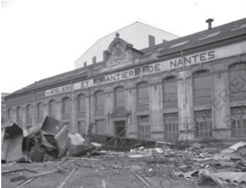
Figure : Bâtiment des chantiers navals après la fermeture en 1987
