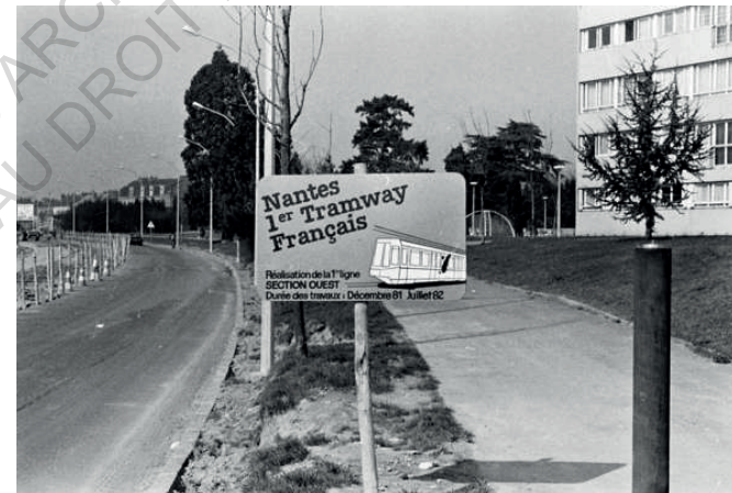
Aménagement de la ligne 1 du tramway © archives municipales, 20Fi3048
