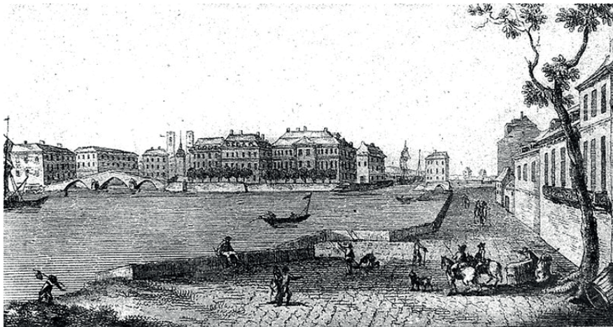
242. ANCIEN NANTES - Vers 1760 — La pointe occidentale de l'île Feydeau et les premières maisons construites Ce qui devint la Petite-Hollande - À gauche, le Pont du Nord ou Feydeau, plus tard, de la Bourse, fut construit vers 1732. À droite, le Pont d'Occident ou Maudit, ne fut édifié qu'en 1778, et encore ce n'était guère qu'une passerelle en bois.
