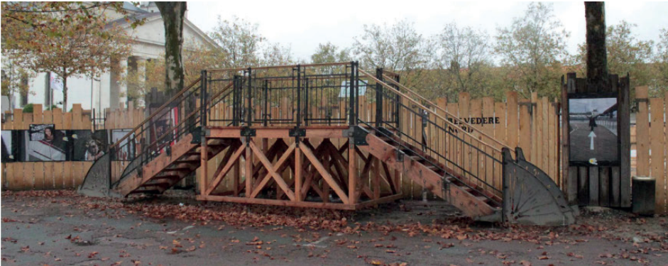
Figure 81 : Belvédères du chantiers de la Place Napoléon
