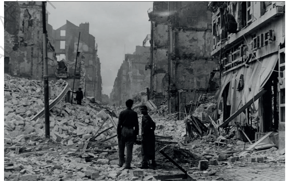
Figure 25 : Débris des bombardements, 1943
