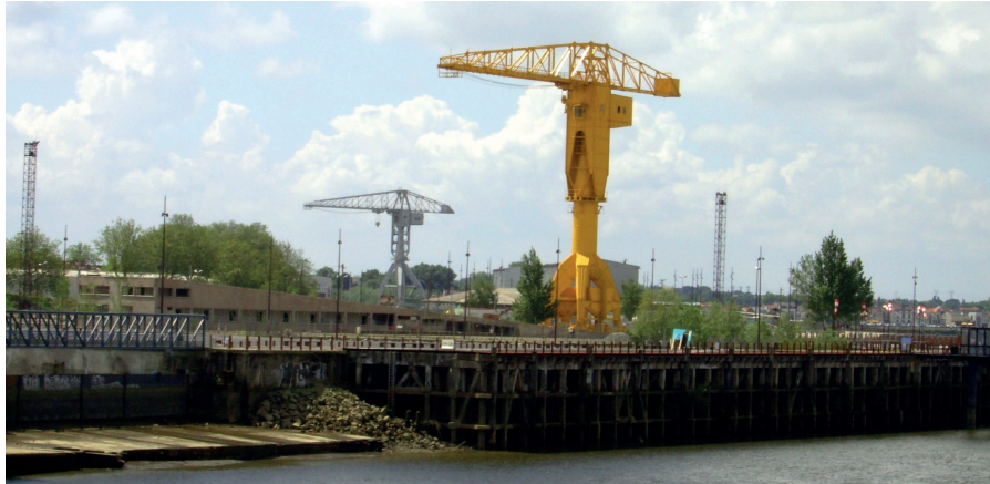
Figure 26 : Grues Titan construites pour aider les chantiers
