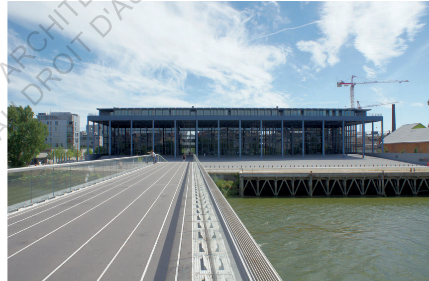
Figure 42 : Palais de justice par Jean Nouvel et passerelle par Barto + Barto
