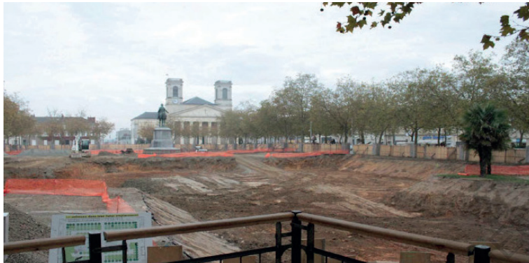
Figure 82 : Vue d'un des belvédères du chantiers de la Place Napoléon
