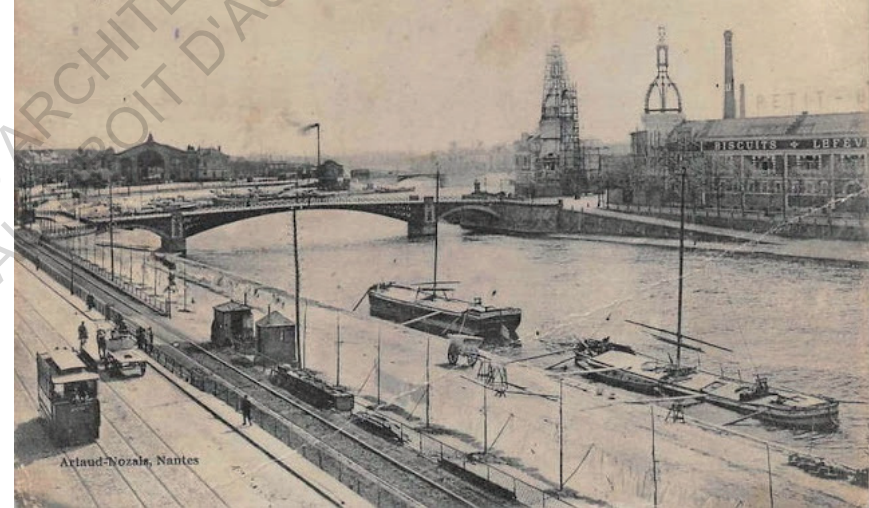
Figure 21 : Berges autour de l'usine LU
