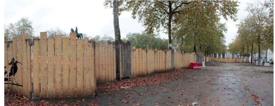
Figure 80 : Palissades de chantiers de la Place Napoléon
