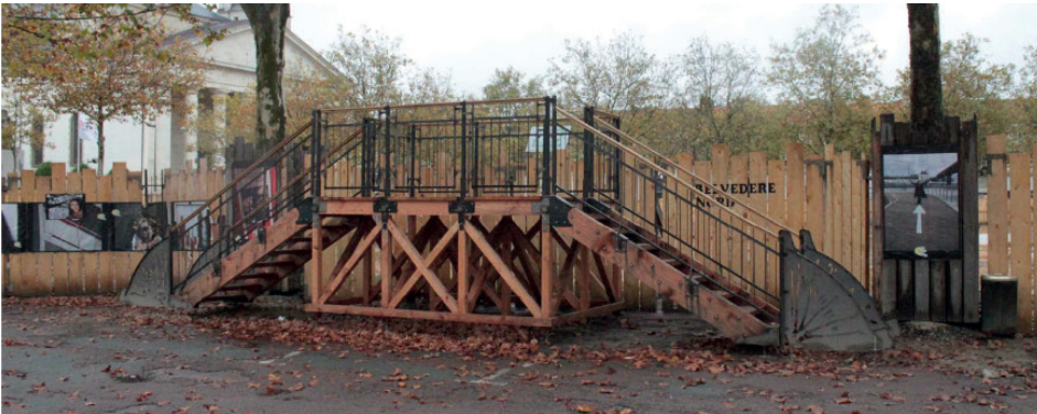
Figure 81 : Belvédères du chantiers de la Place Napoléon
