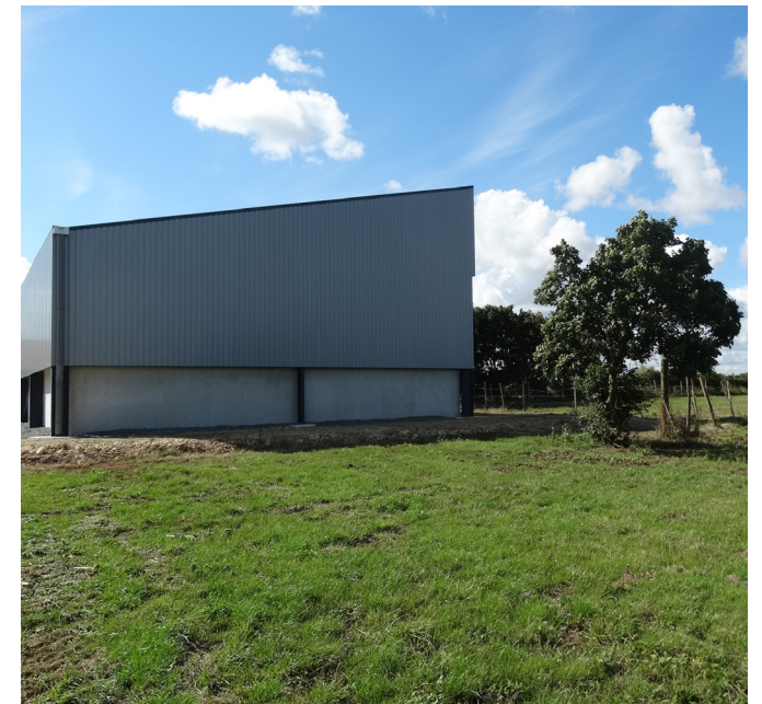
Bardage métallique gris et toiture mono-pente. Photographie personnelle.
