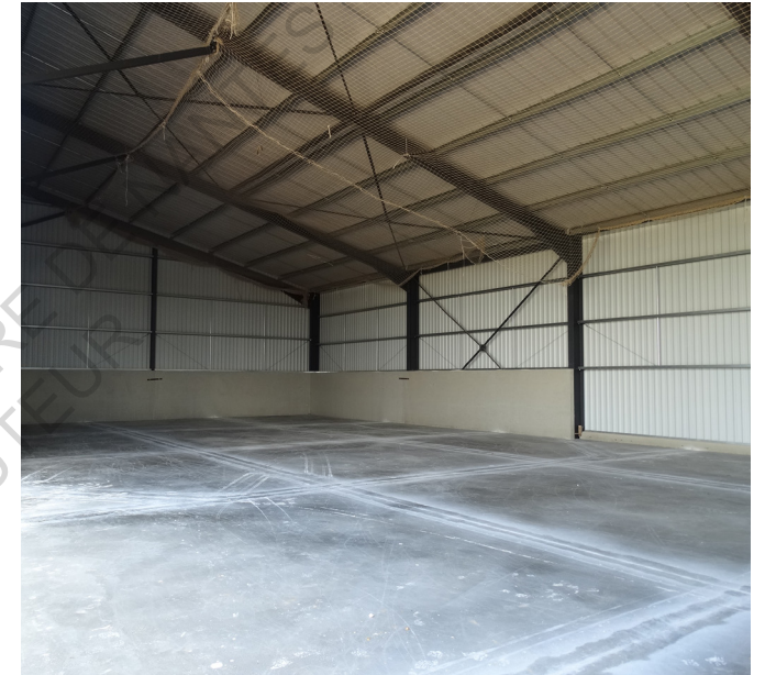
Zone de stockage à plat avec béton banché. Photographie personnelle.
