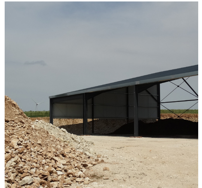
Stockage du composte à l'ombre du hangar. Photographie personnelle.
