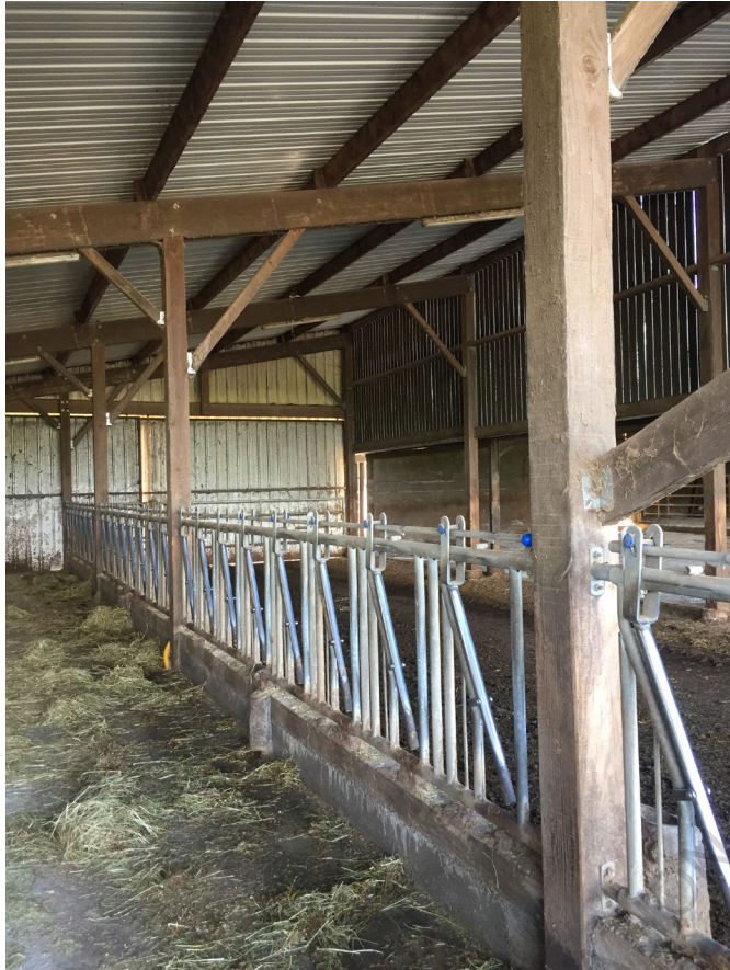
Fig. 16: Utilisation d'une charpente bois et d'un bardage à claire-voie dans une stabulation. Photographie personnelle.
