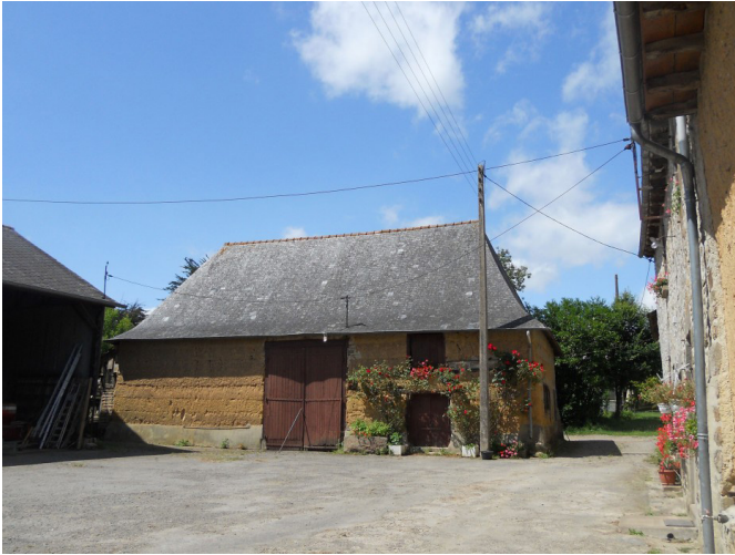
Fig. 01: Une grange en bauge du XVII ème siècle en Ile et Vilaine. (Atelier ALP)
