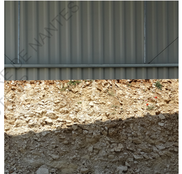
Dialogue entre le bardage métallique et le sol calcaire. Photographie personnelle.
