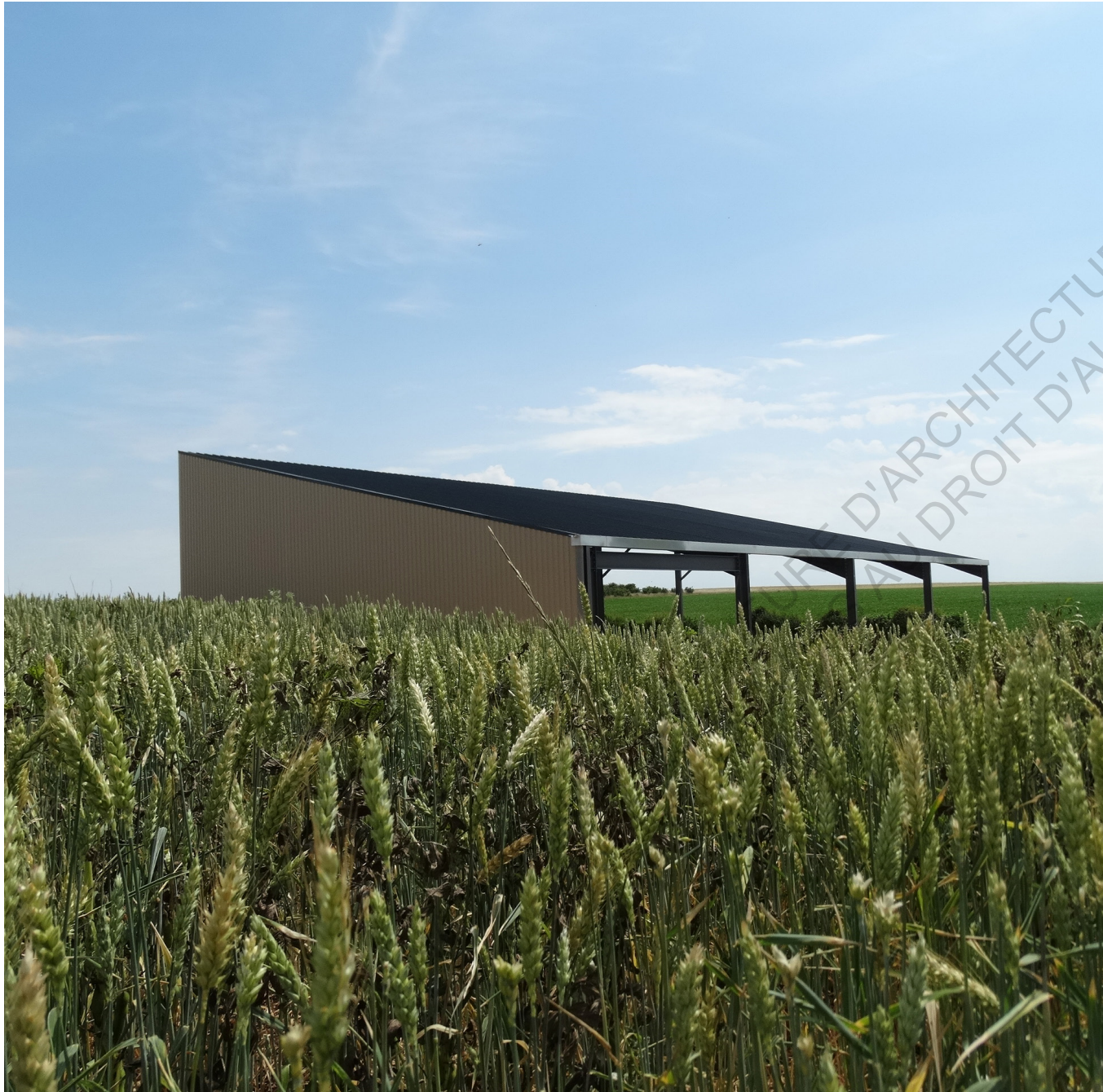
Le bâtiment de stockage vu deus les champs. Photographie personnelle.
