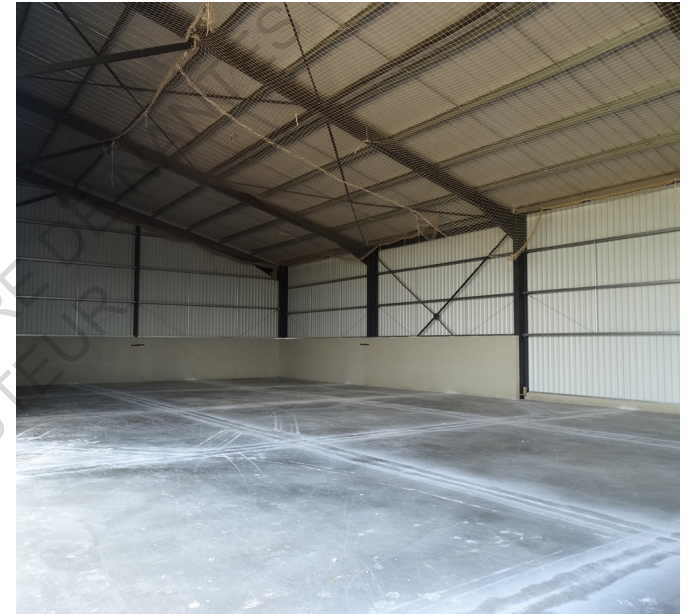
Zone de stockage à plat avec béton banché. Photographie personnelle.
