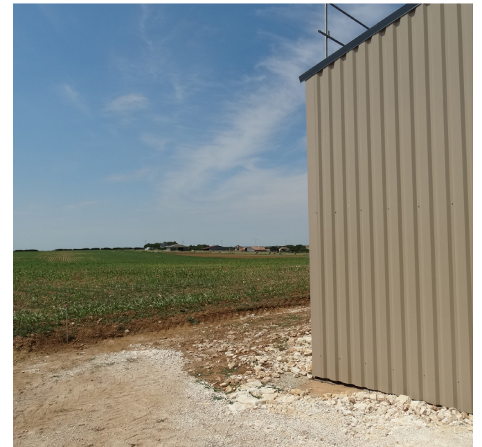
Bardage métallique couleur taupe en façade. Photographie personnelle.
