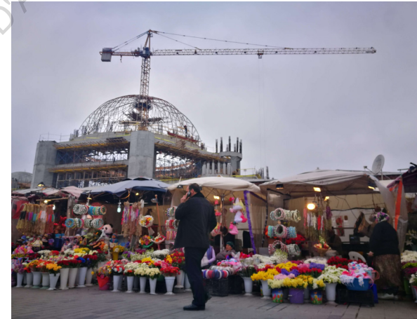
Construction de la mosquée, Taksim, Petit Journal, 2018
