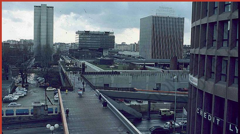
Figure 23. La dalle de la Part-Dieu à Lyon, superposition des voies.
