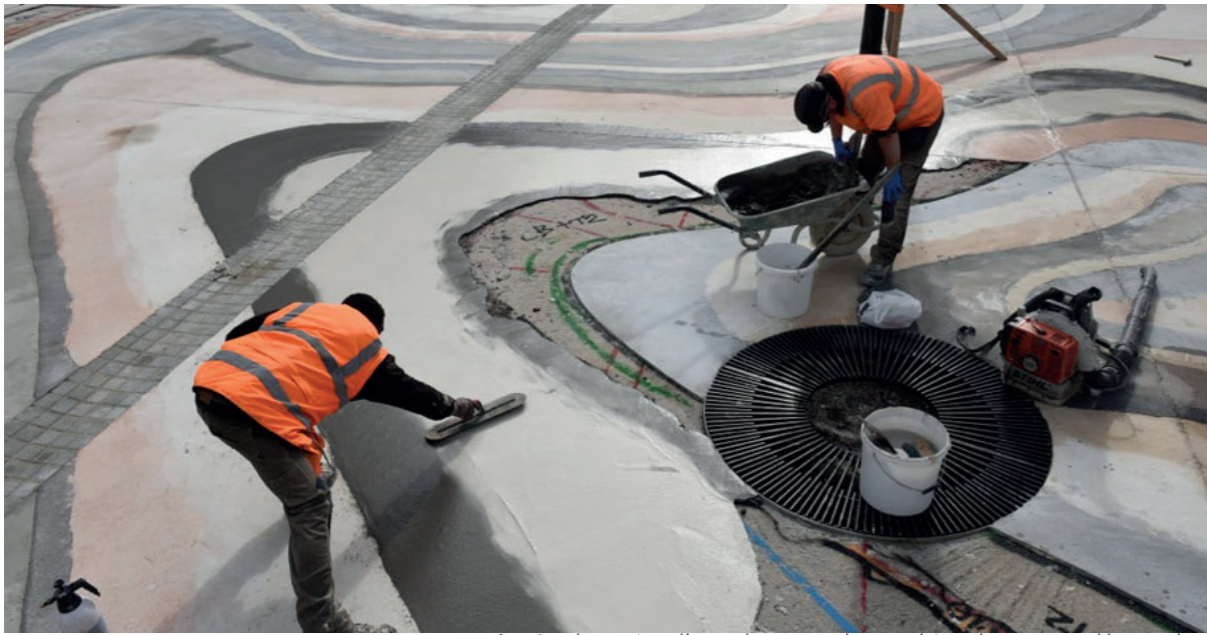
Fig.49: Rénovation d'une place avec des matériaux locaux recyclés sur place
