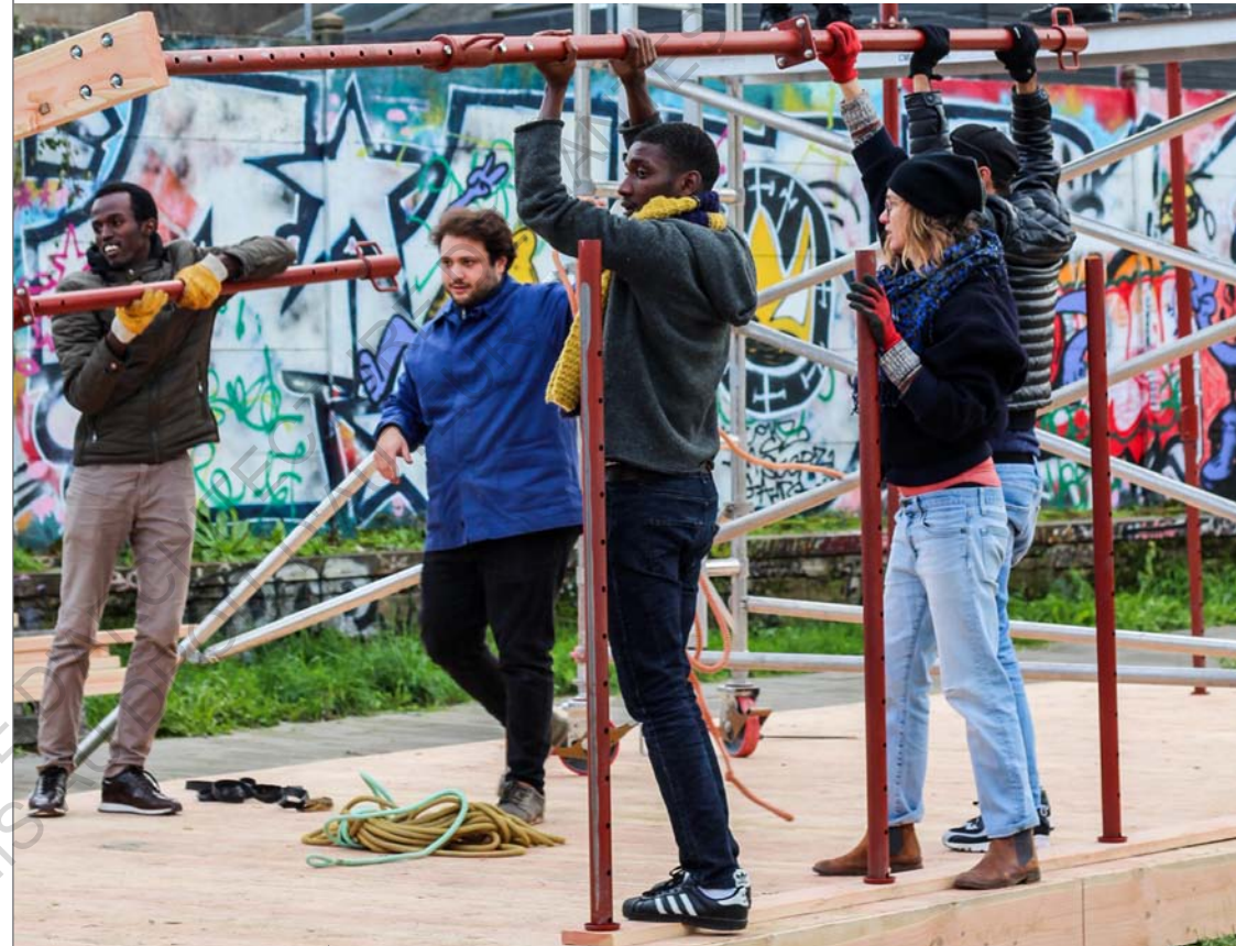
Illustration 8 Scène de chantier pendant la construction de la Nizanerie, avec l'aide de bénévoles © GRU
