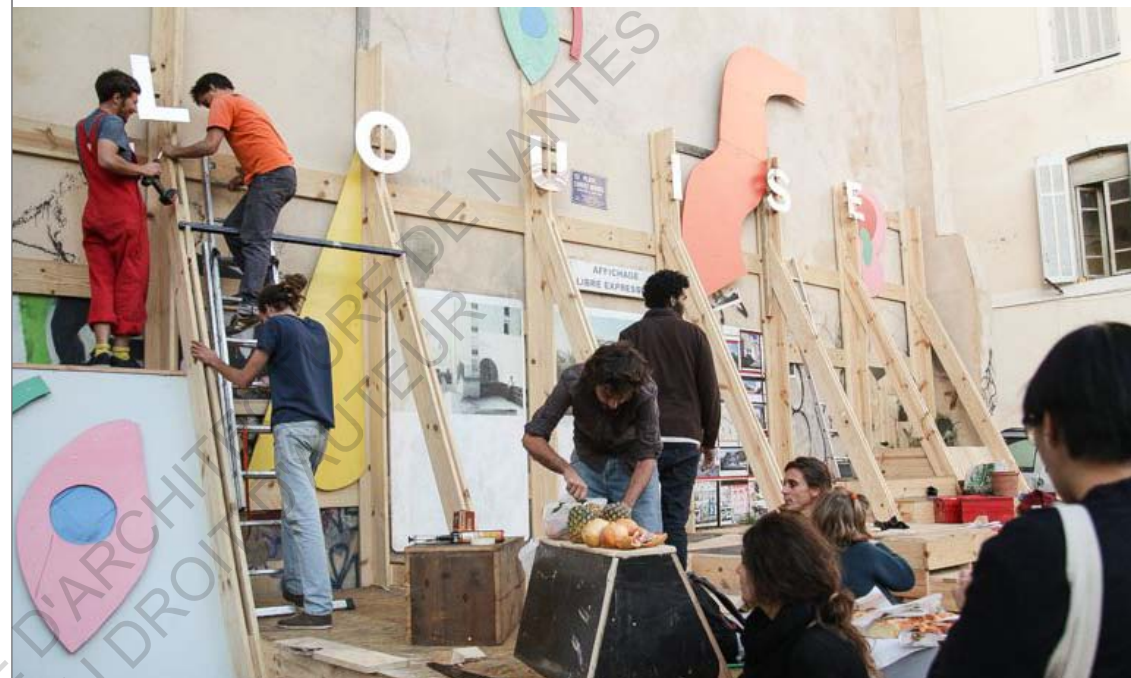
Illustration 4 Scène de chantier lors de la réalisation du projet Belsunce Tropical par le collectif ETC et des bénévoles © ETC
