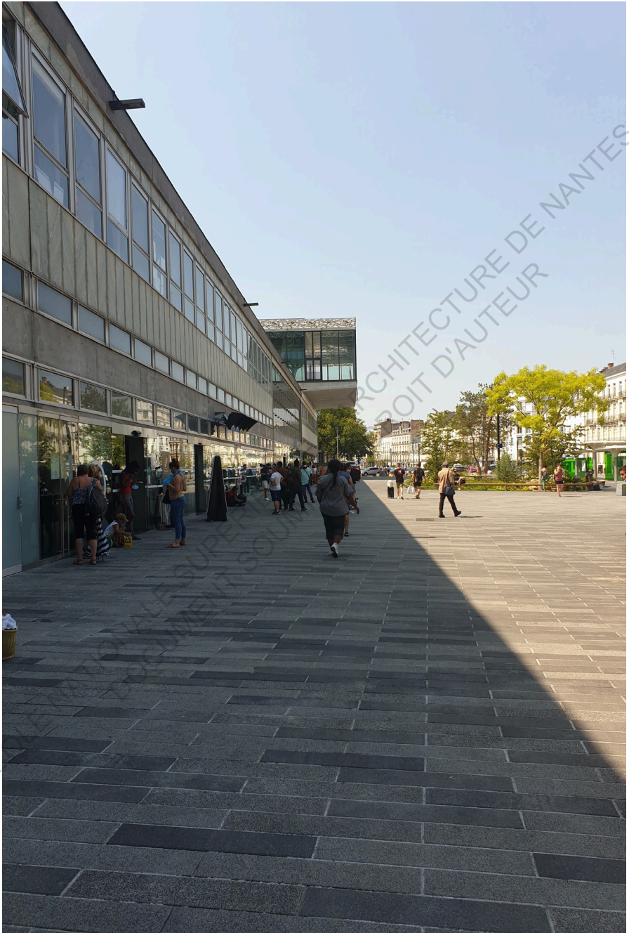
Fig 41. Au loin, la mezzanine se dessine au-dessus du bâtiment, été 2020
