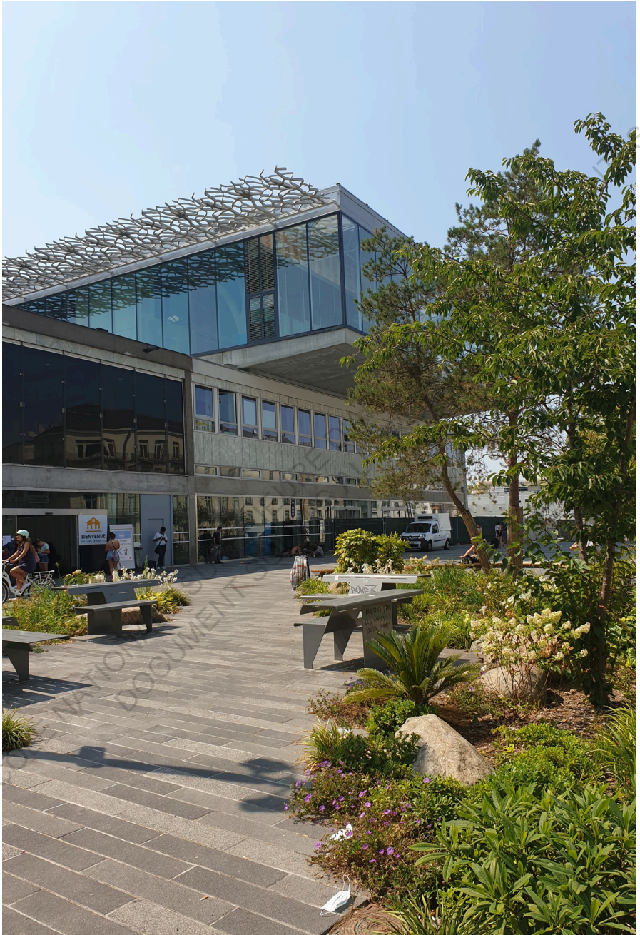
Fig 1. Chantier en cours, été 2020
