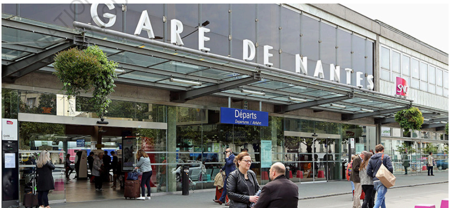
Fig 8. La Gare Nord, avant le début des travaux
