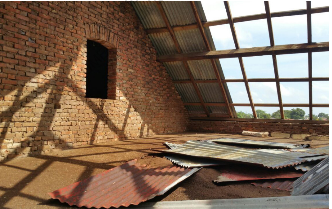
Travaux sur une maison de la pénitencière, 2017 ©Yves Bhagooa
