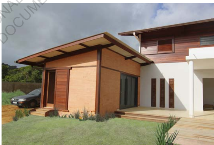
Utilisation de la brique et du bois comme matériaux de construction au sein d'une maison guyanaise. Photos ©Amarante architecture
