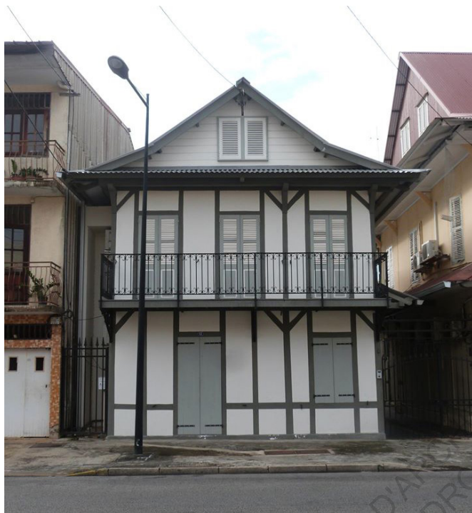
Pôle architecture ville patrimoine - Cottalorda & Pérès - 2014 - 13 av. Léopold Héder, Cayenne "Réhabilitation d'une maison créole en bureaux. Extension contemporaine à l'arrière, avec façade originale pléée en zig-zag et composée de briques de bois ajourées." Extrait de la carte des curiosités architecturales et paysagères de Cayenne ©Maison de l'architecture de Guyane
