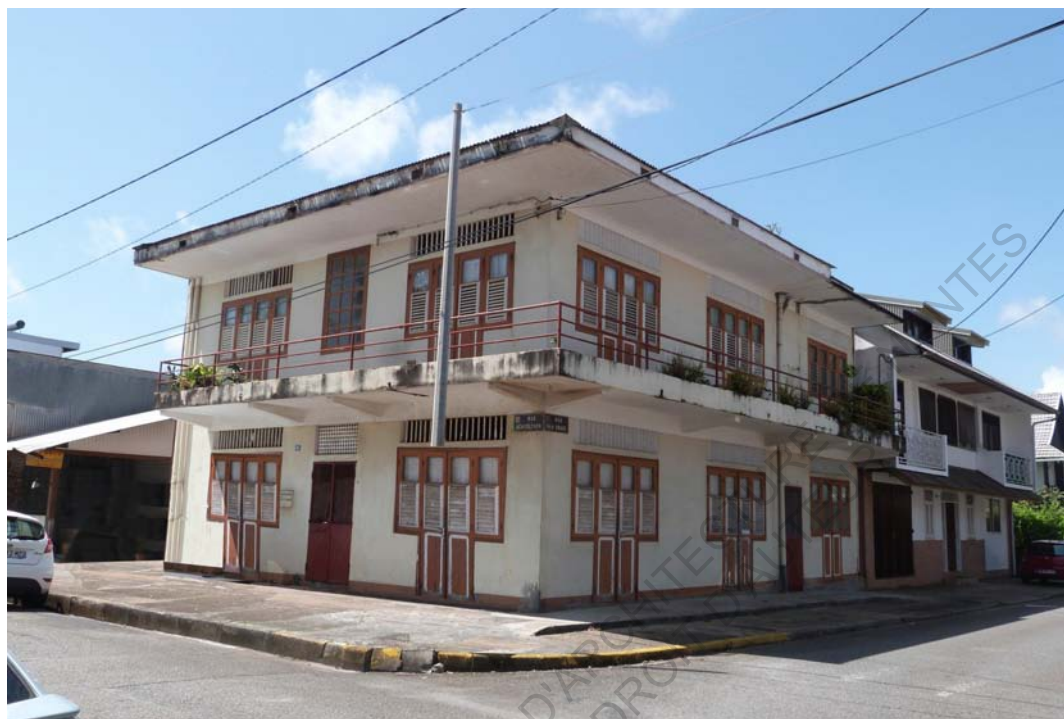
Maison individuelle - Architecte inconnu, milieu 20 e siècle - 66 rue Schoelcher, Cayenne "Toiture plate et orthogonale offrant une protection contre le soleil et la pluie. Usage d'éléments traditionnels pour ventiler: impostes à lames verticales et persiennes." Extrait de la carte des curiosités architecturales et paysagères de Cayenne ©Maison de l'architecture de Guyane
