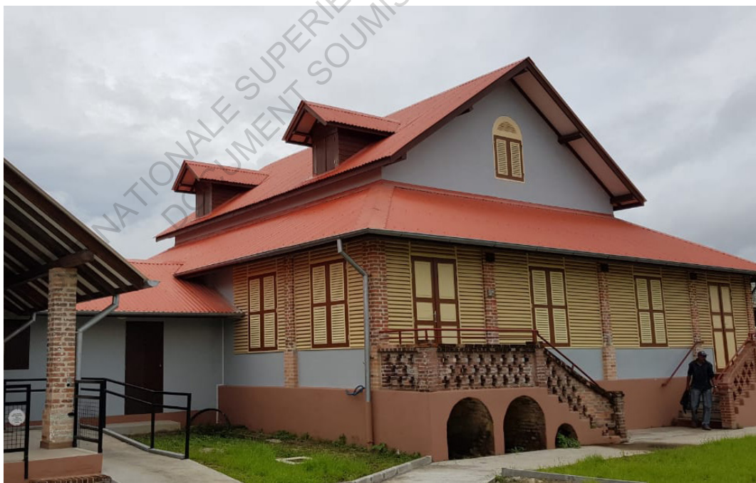
Certains habitants, soucieux de préserver le patrimoine, se lancent dans la réhabilitation de ces maisons. En transformant les combles en étage, ils rentabilise l'espace, 2019 ©Yves Bhagooa
