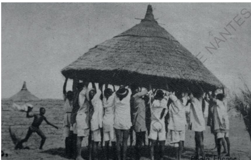
Figure 20: Edification collective d'une case dans le mossi
