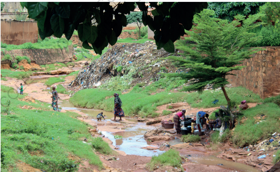
Figure 70: Lit de la rivière Houet à Bobo Dioulasso
