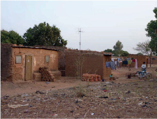
Figure 76: 6 tôles illégalement raccordé à l'électricité de la ville lotie voisine
