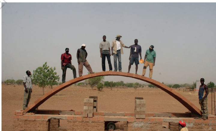
Figure 107: Enseignement de l'ingénierie avec l'expérimentation d'une voute en briques
