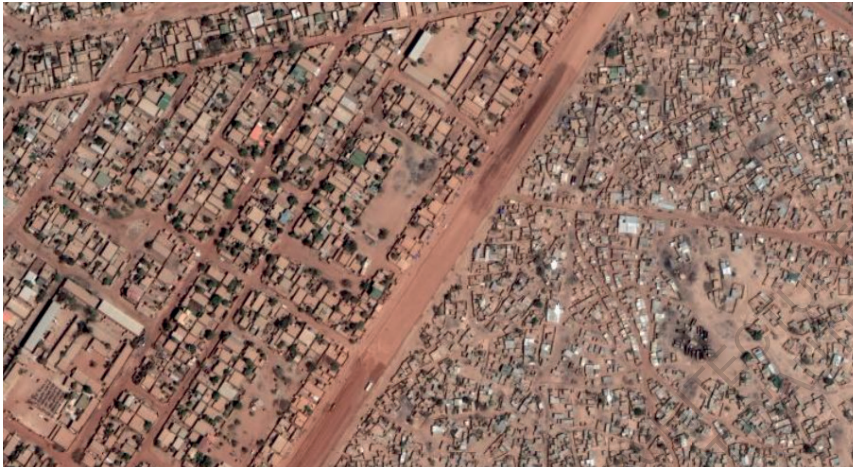
Figure 39: Vue aérienne au Nord-Est de Ouagadougou à gauche la «ville planifiée» et à droite la «ville spontanée»
