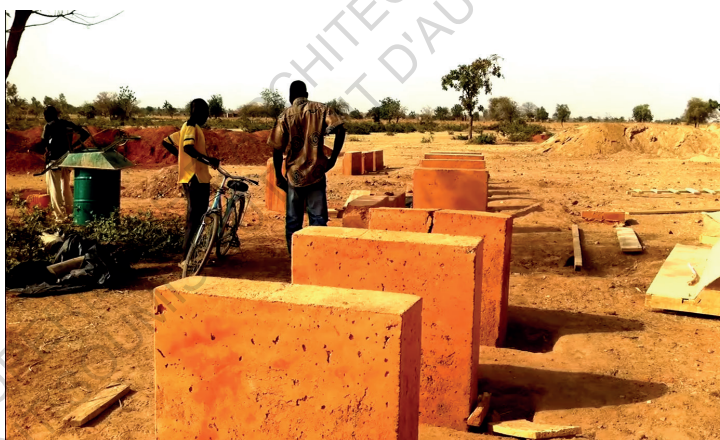
Figure 106: Expérimentation de la terre coulée à la manière du béton
