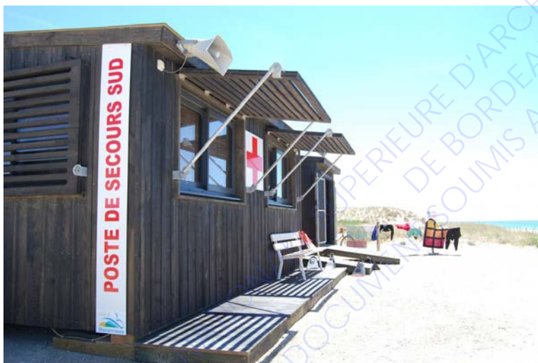
Poste de secours mobile en pin et cartographie répertoriant son installation sur le littoral
