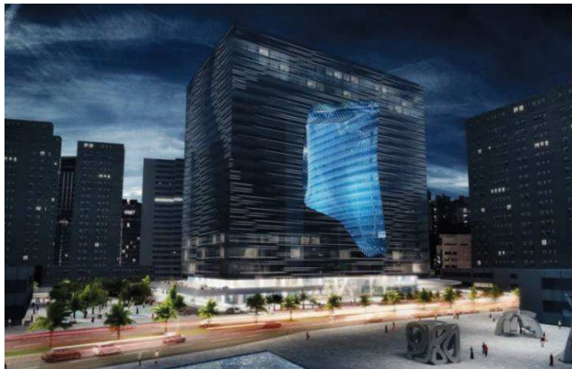
Figure 18 : Vue de The Opus à Dubaï
