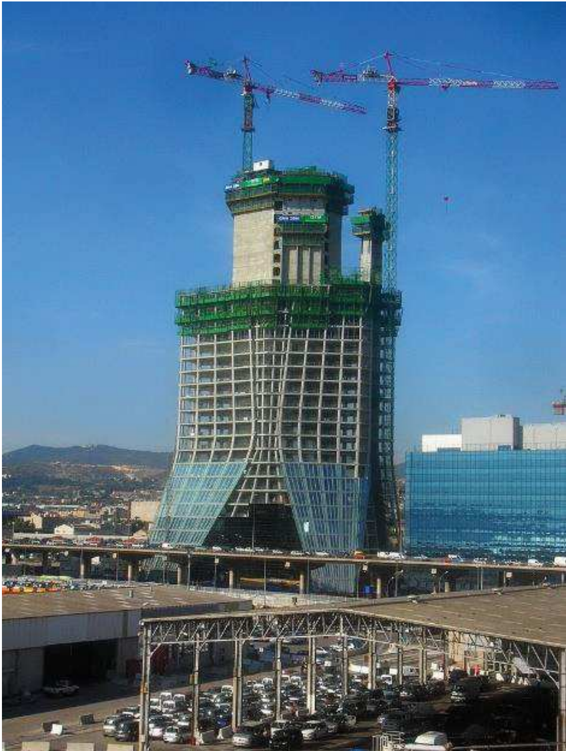
Figure 9 : Colonne centrale du siège social de la CMA CGM
