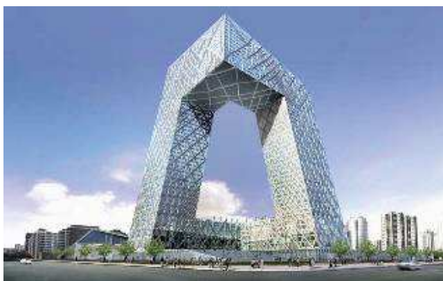
Figure 22 : Siège social de la CCTV
