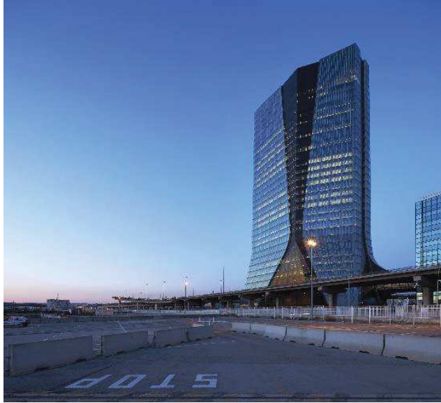
Figure 46 : Vue façade extérieur 1
