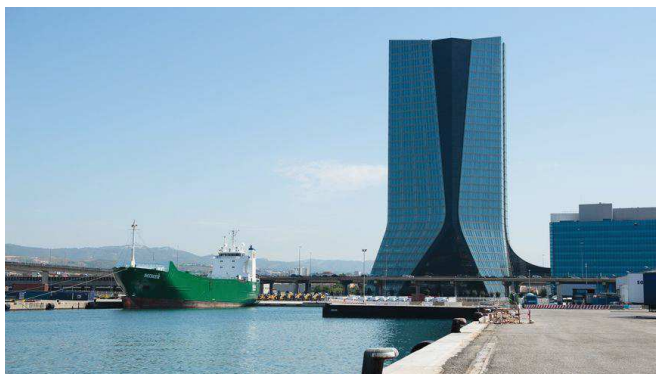
Figure 50 : Vue façade extérieur 3
