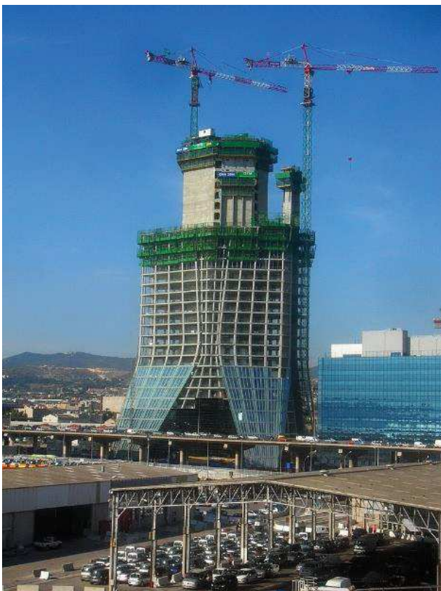
Figure 47 : Vue extérieur construction
