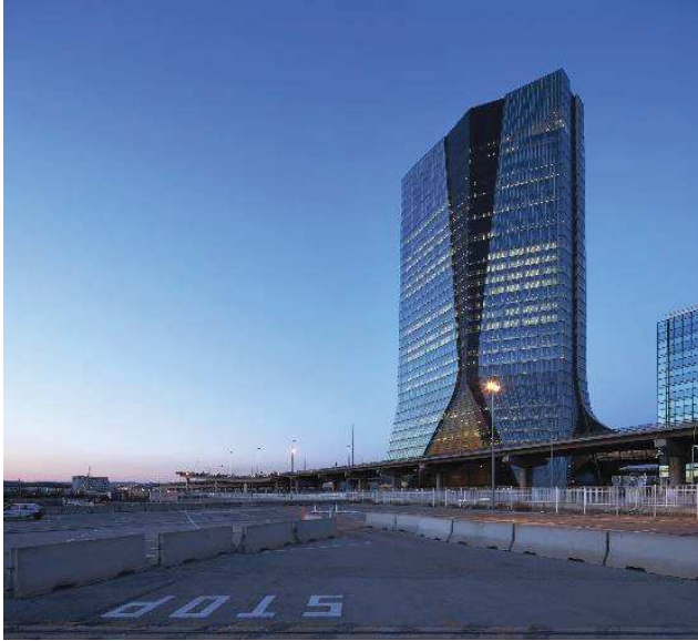
Figure 46 : Vue façade extérieur 1
