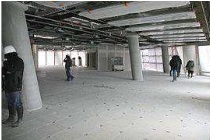
Figure 79 : Vue poteaux intérieurs
