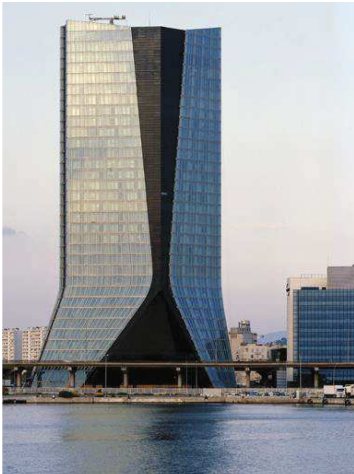
Figure 52 : Vue façade extérieur 5
