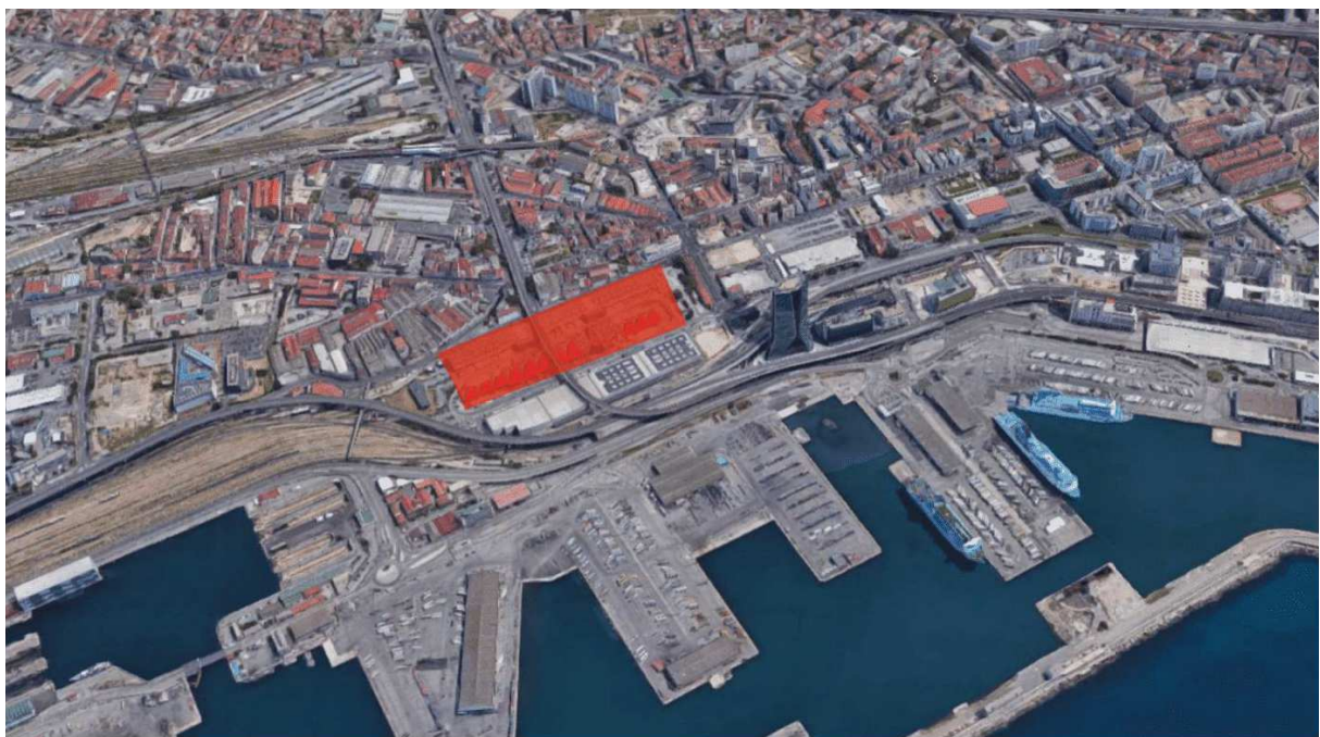
Figure 84 : Vue aérienne de l'extension de la skyline
