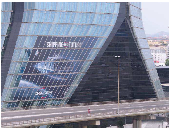
Figure 49 : Vue affichage façade
