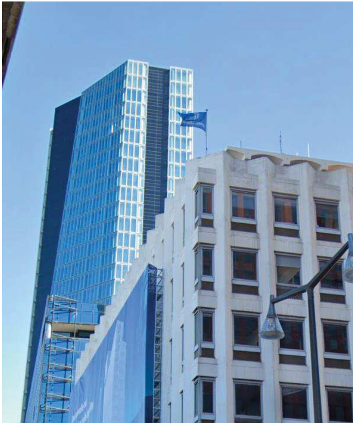
Figure 12 : Vue du bâtiment de profil
