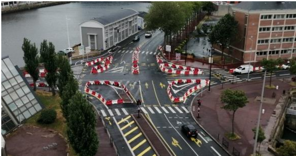
Figure 14: Carrefour aménagé "à la hollandaise" au Havre Chaussée Georges Pompidou, Le Havre. Photo : Simon FESSARD
