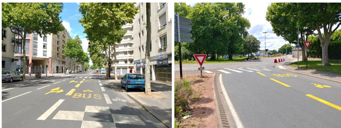
Figure 16: Exemples de voie bus-vélo temporaires à l'approche des intersections Cours Gambetta, Lyon // rond-point Charles de Gaulle, Rillieux-la-Pape Photos : Louis-Charles PESANT
