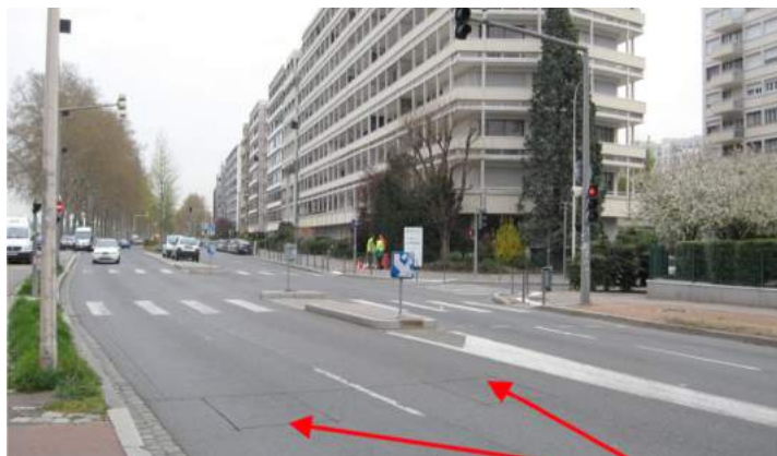
Figure 19 : Les flèches rouges désignent des boucles de comptage pour véhicules motorisé dans une rue (Grand Lyon, 2019)
