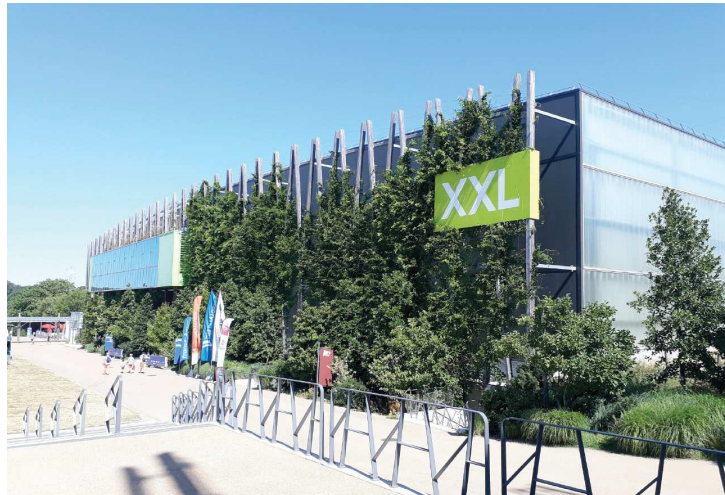
Hall XXL - Vue à droite, une fois le bâtiment d'entrée traversé (en haut des escaliers)
