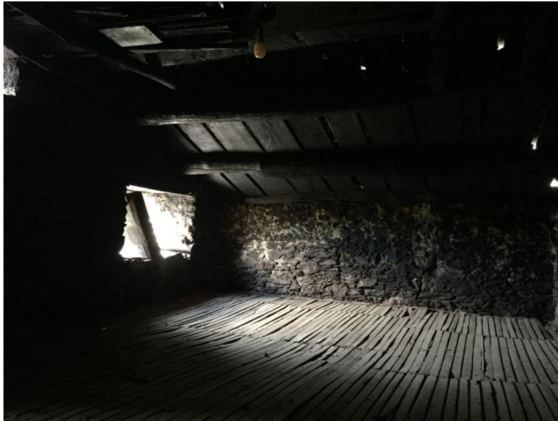
Figure 17 : étage supérieur d'un séchoir. Sur le mur de gauche, trois fenêtres permettent de contrôler les courants d'air. Sur le mur de droite, une porte permet de déposer les châtaignes sur les clais. (Nocario, 15/06/2020)© Doria Bellache.
