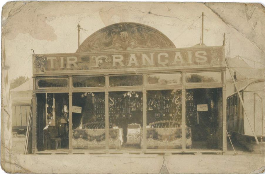
Figure 50 - Premier état du Tir-salon
