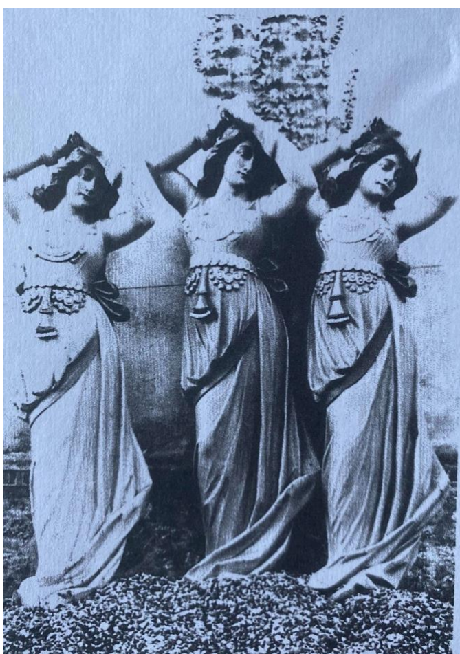
Figure 54 - Statues lumineuses de l'Hippo-Palace
