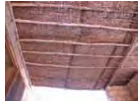
auvent avec couverture végétale
