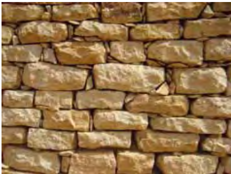
Maçonnerie pierres sèches régulière
