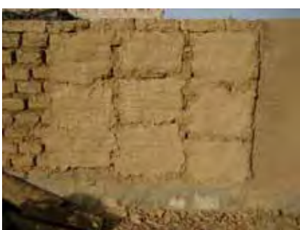
tests pour le dosage de ciment et foin de fonio
