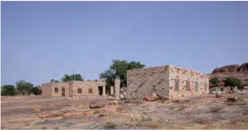
une école à Beignemato architecte : Peeyush SEKHSARIA
