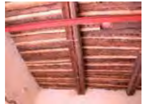
toiture-terrasse en rônier et terre
