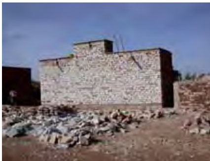
mur en pierres de Ficko achevé
