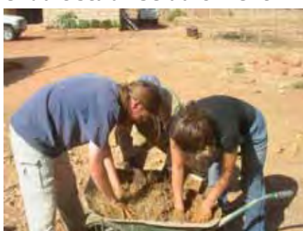
enduit banco jaune stabilisé à 4% de ciment et 1/3 (vol.) de fonio
