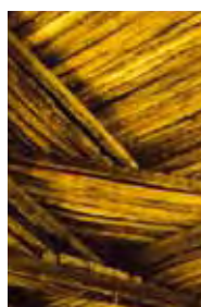
toiture en rôniers image : W. Lauber
