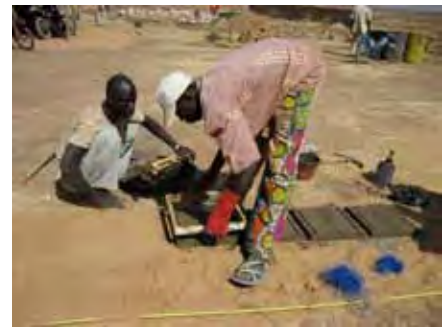
moulage des dalles en ferro-ciment
