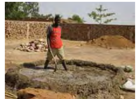
préparation du banco pourri pour la dernière couche de toiture
