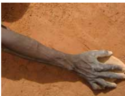
... tapé avec une pierre et lissé avec un morceau de calebasse
