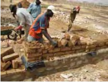
maçonnerie briques de banco
