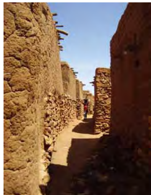
ruelle formée par les bâtiments et les clôtures des concessions
