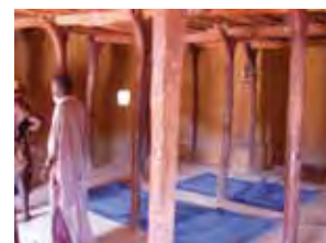
intérieur : enduit jaune et poteaux
