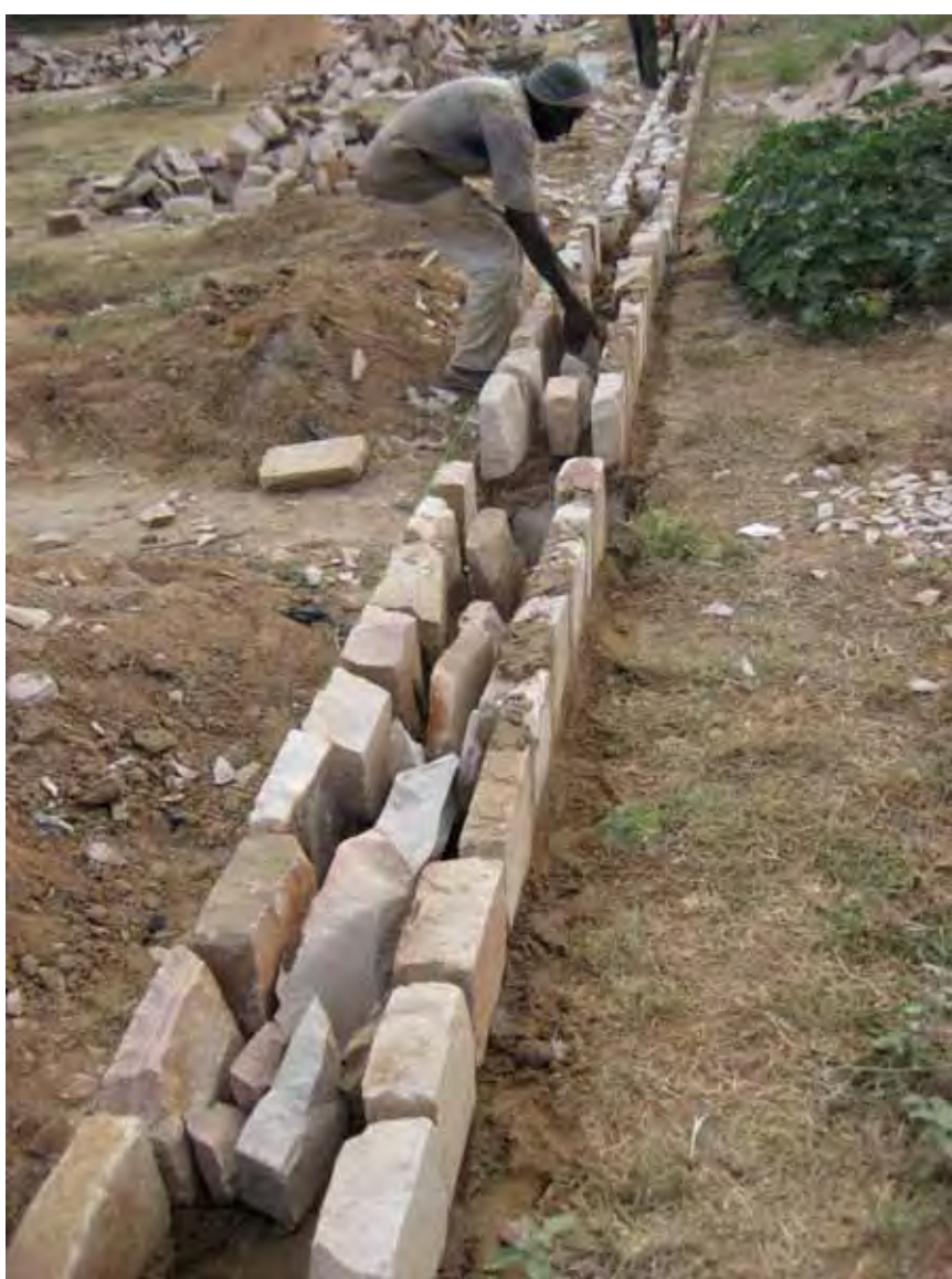
soubassement-fondation sur un chantier à Bandiagara
