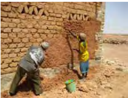
enduit en latérite pilée par des maçons de Bandiougou
