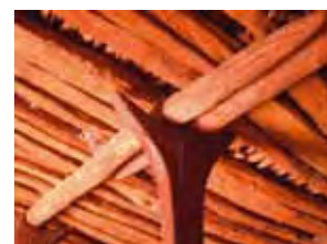
charpente : perches rapprochées (30 cm)
