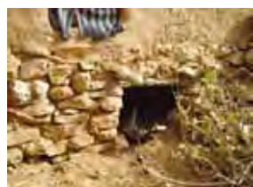
soubassement : pierres non-taillées maçonnées au banco sur 80 cm de hauteur
