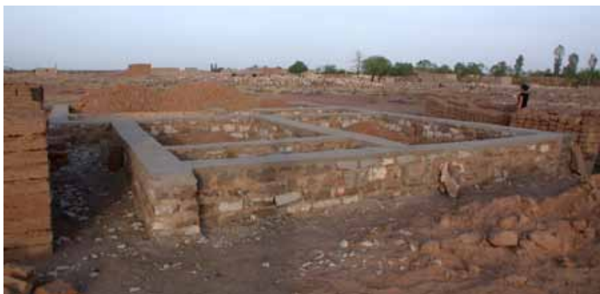
état d'avancement à notre départ : barrière capillaire ciment terminée
