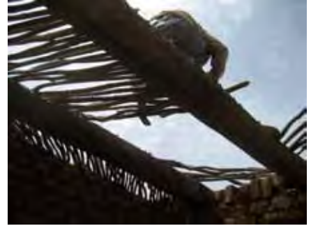
charpente : rôniers et perchettes
