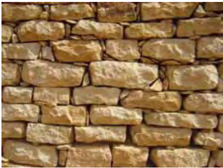
Maçonnerie pierres sèches régulière
