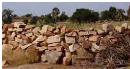
clôture utilisant grosses et petites pierres
