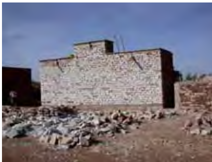
mur en pierres de Ficko achevé
