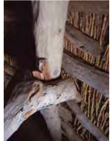
Charpente traditionnelle en gondio
