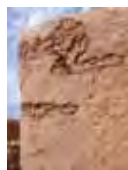
murs : briques « tiemié » fabriquées avec du banco "de rivière" trempé 24 h
