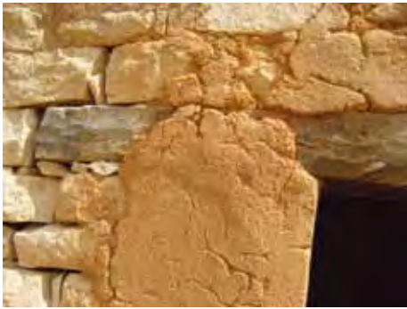
Enduit terre de termitière autour de la porte
