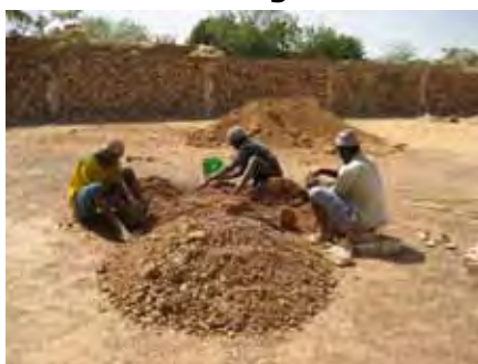
enduit "bandiougou" : gravier latéritique pilé mouillé...
