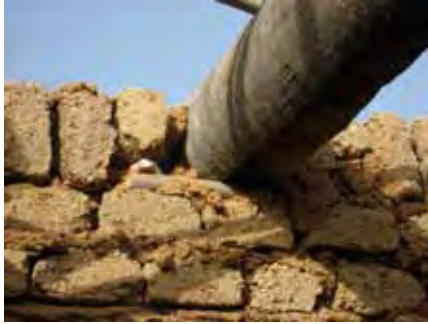
perchettes pour répartir les charges sous la poutre
