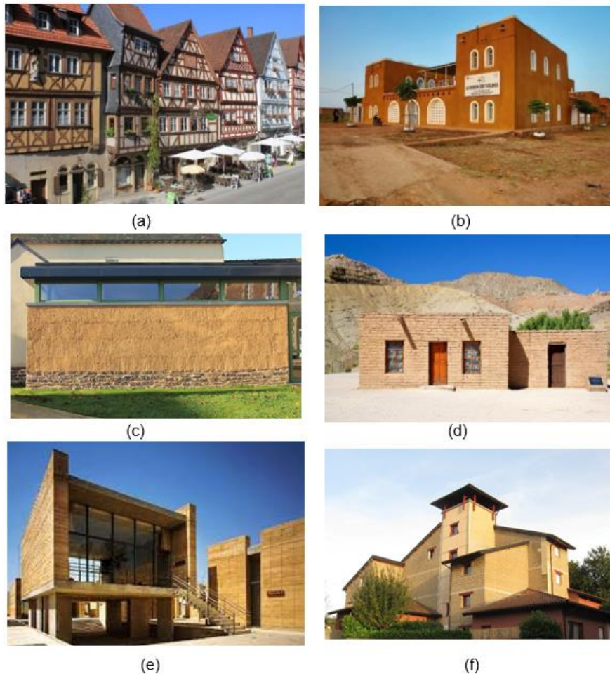
Figure 1: (a) Timbered houses in Ochsenfurt (Allemagne)-(b) "Maison des Yvelines" rendering with raw earth in Ouroussogui (Sénégal)-(c) Cob wall of the library of Muël (France)-(d) "El casa de Adobe : el poder en el desierto" in Chihuahua (Mexico)-(e) Oaxaca art school in Mexico-(f) "Le Domaine de la Terre" in Villefontaine (France)
