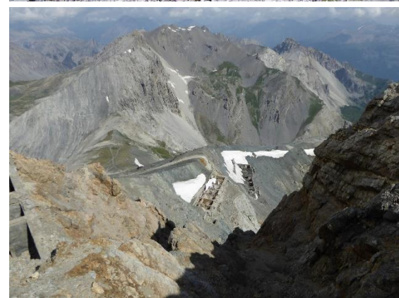
Figure 9. Tourelles, casemate et vue depuis le fort du Chaberton (Photographies : Franck Michel)
