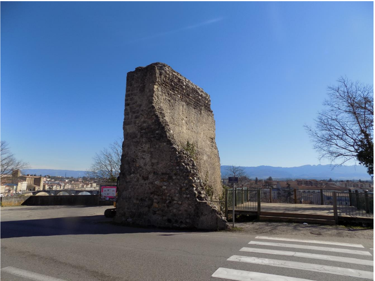
Image n°3 : Vestige des rempart du XIV e siècle : rempart coteau Chapelier actuelle côte des Chapeliers
