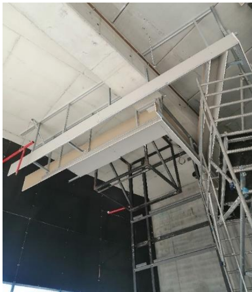
Figure 24 : Photographie de la mise en œuvre de la jouée en plâtre et structure acier
