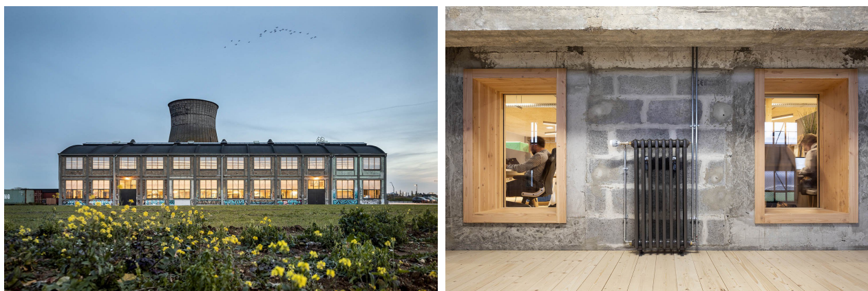
Figure 25 : La Grande Halle de Colombelles ayant bénéficié du permis d'expérimenter. Source : encoreheureux.org
