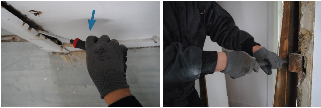
Figure 15 : Étapes de dépose supplémentaires et soignées, recommandées par Reuse. Source : Reuse.brussels
