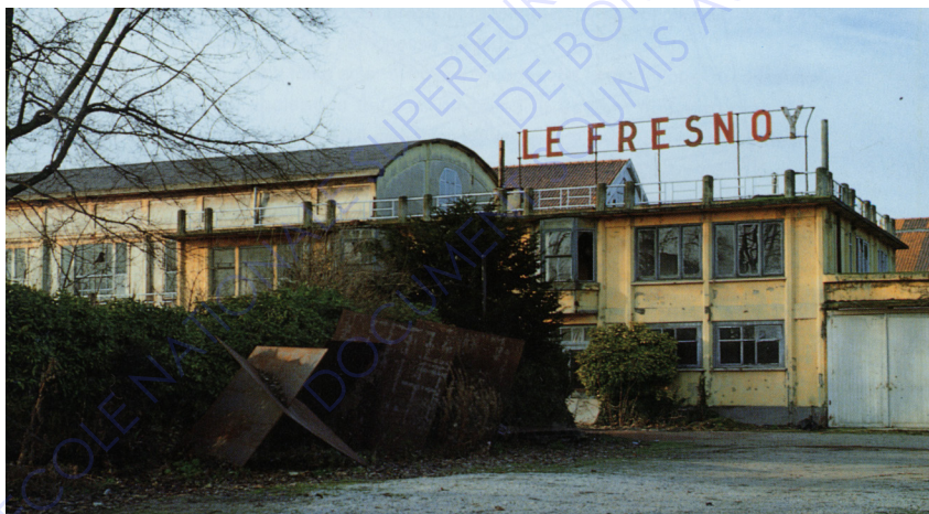
Fig. 29. Le Fresnoy avant son opération de réemploi
