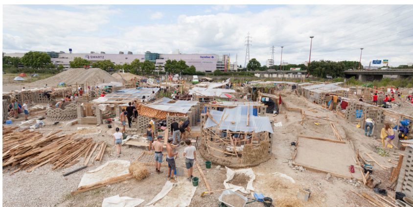
Fig. 51. Festival Bellastock 2017 portant sur la question de la terre crue en réponse aux 50 millions de terre excavée à la suite des travaux du Grand Paris
