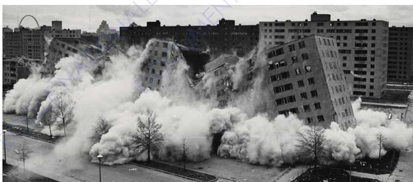
Fig. 24. Démolition du deuxième immeuble de Pruitt-Igoe en 22 avril 1972
