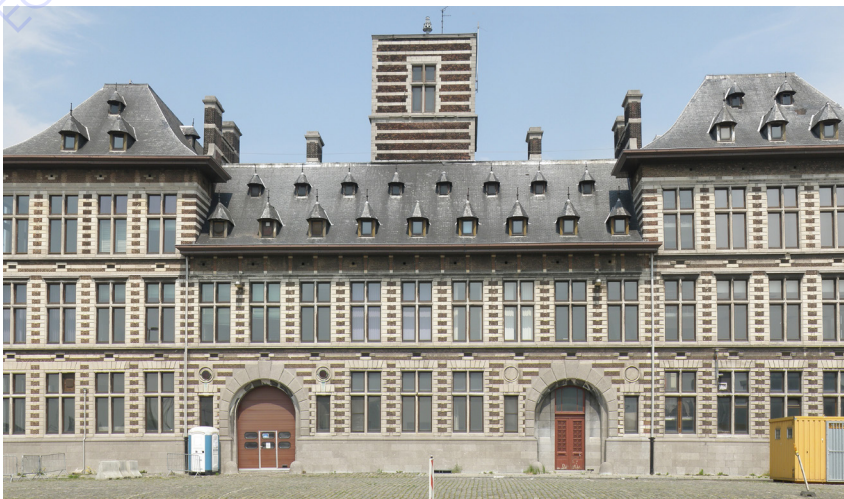
Fig. 27. Ancienne caserne des pompiers du port d'Anvers où l'on peut voir un reliquat de la volonté de créer une tour
