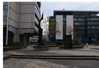
2. Un espace ouvert de jour comme de nuit sur la vaste dalle de Meriadeck, favorisant le passage et une logique éclatée par des éléments architecturaux qui viennent créer des situations de dissimulation
