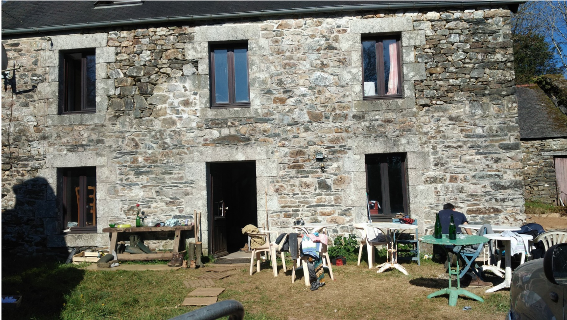
Figure 10: Façade sud de la maison de confinement. Photo : Léa
