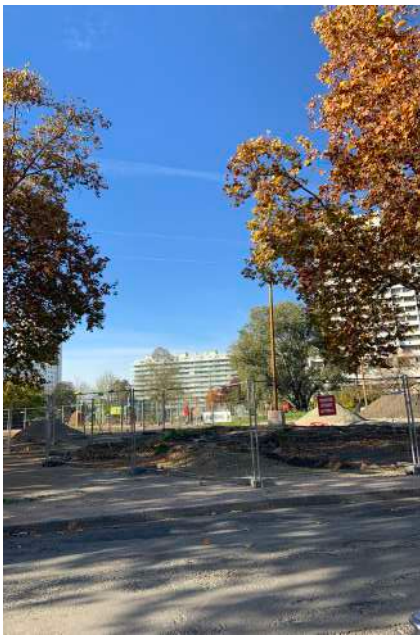
Travaux du Parc du Grand Parc
