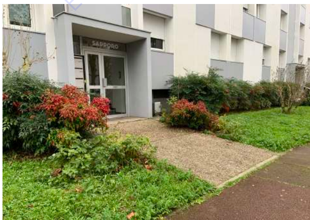
Accès PMR et habillage de façades.
