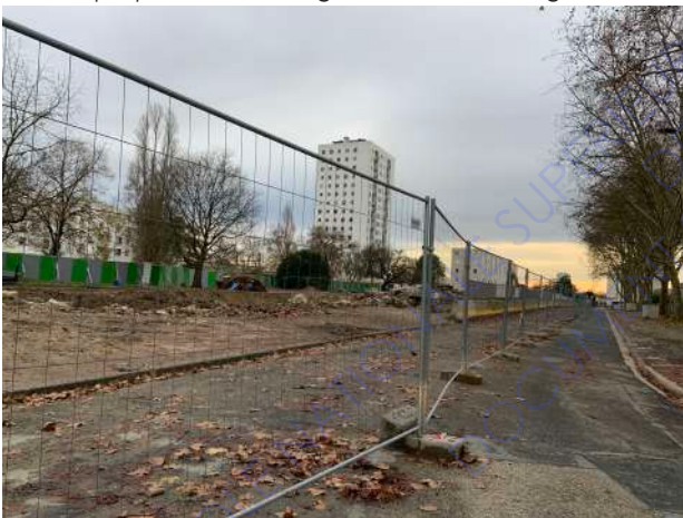
Travaux en cours à La Bénauge.
