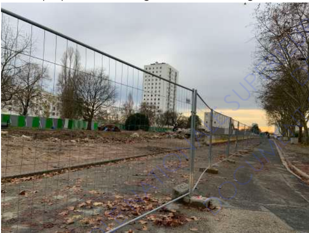
Travaux en cours à La Bénauge.
