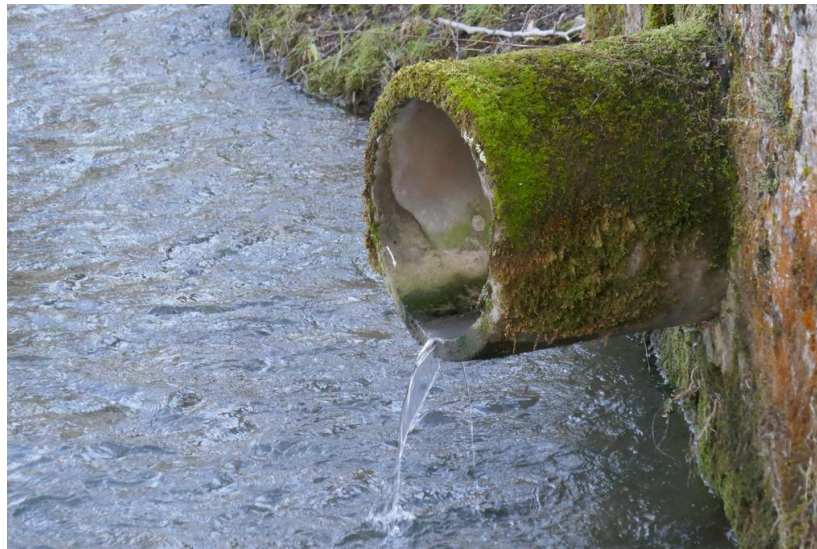
Figure 1. Photographie d'un déversoir d'orage (source : GRAIE)
