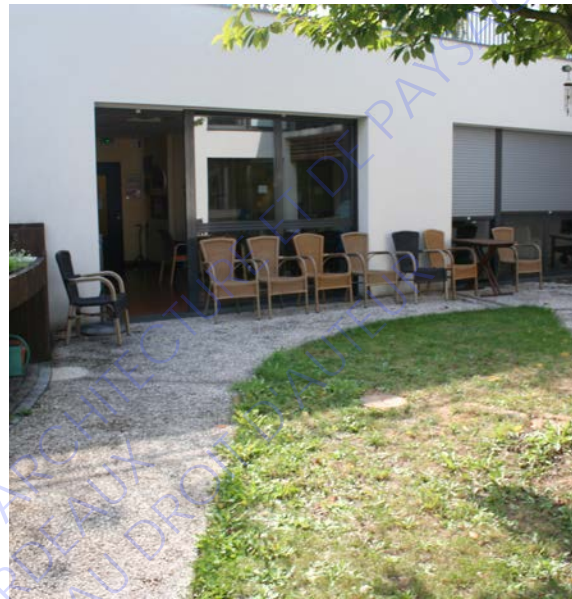
Figure 25 : Largeur du cheminement engendrant des chutes - source photo personnelle
