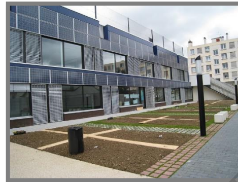
Ecole Jean Louis Marquèze, panneaux solaires pour capter l'énergie 126
