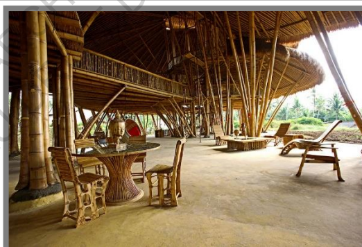
Green School, une école réalisée tout en bambou – de la structure au mobilier intérieur – matériaux local
