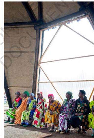
La structure de la salle est faite de poteaux d'eucalyptus peints avec de l'huile moteur recyclée; la toiture est faite avec des tôles galvanisées et des tiges de papyrus. Des feuilles translucides ont été utilisées pour les portes et fenêtres; des tapis d'herbes tissés pour le plafond. Le bâtiment a une hauteur totale de 6 m et dispose de deux portes translucides de type garage qui peuvent être ouvertes pour augmenter la taille et la flexibilité de l'espace.<sup>80</sup>
