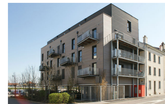
Figure 20 _ Immeuble passif de logements collectifs, Nancy, 2010.
