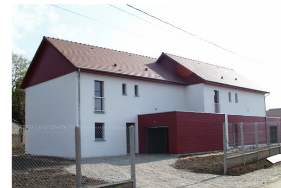
Figure 23 _ Photo des deux maisons mitoyenne, Les Airelles.
