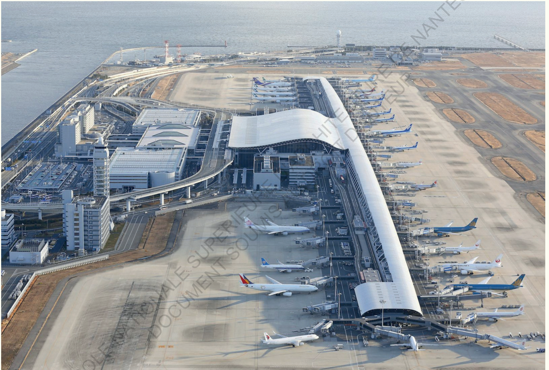
FIG. 24 : Photographie de l'Aéroport International du Kansai, Osaka.
