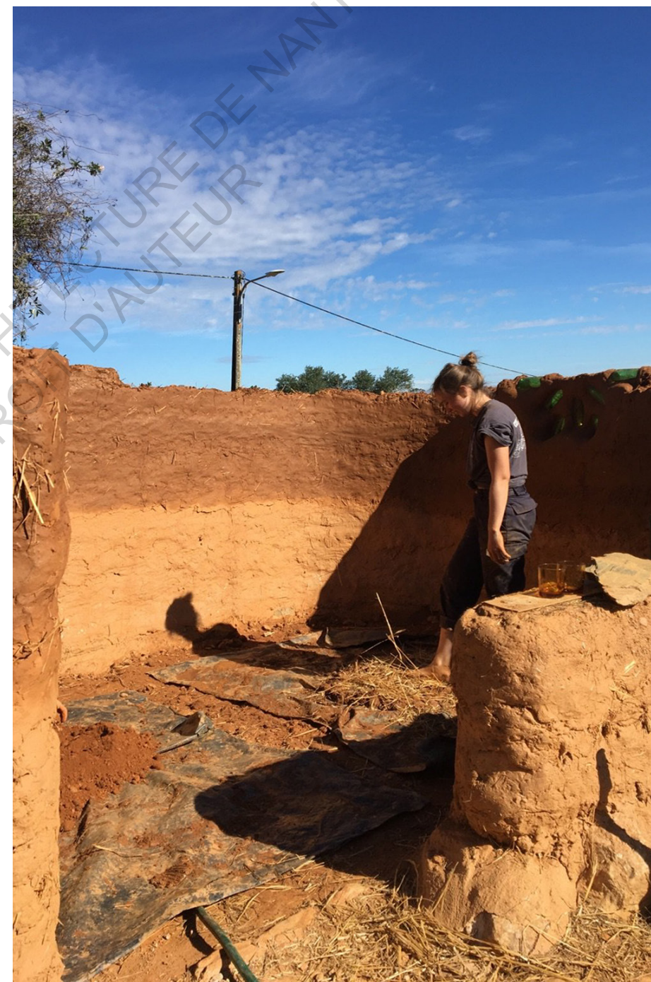
Construction d'une infirmerie pour une école SDE São Luís 10/2020
