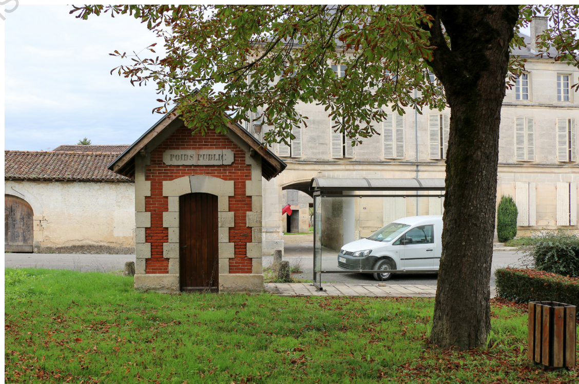
Fig. 73 Le poids public de Mérignac, vu depuis la place centrale
