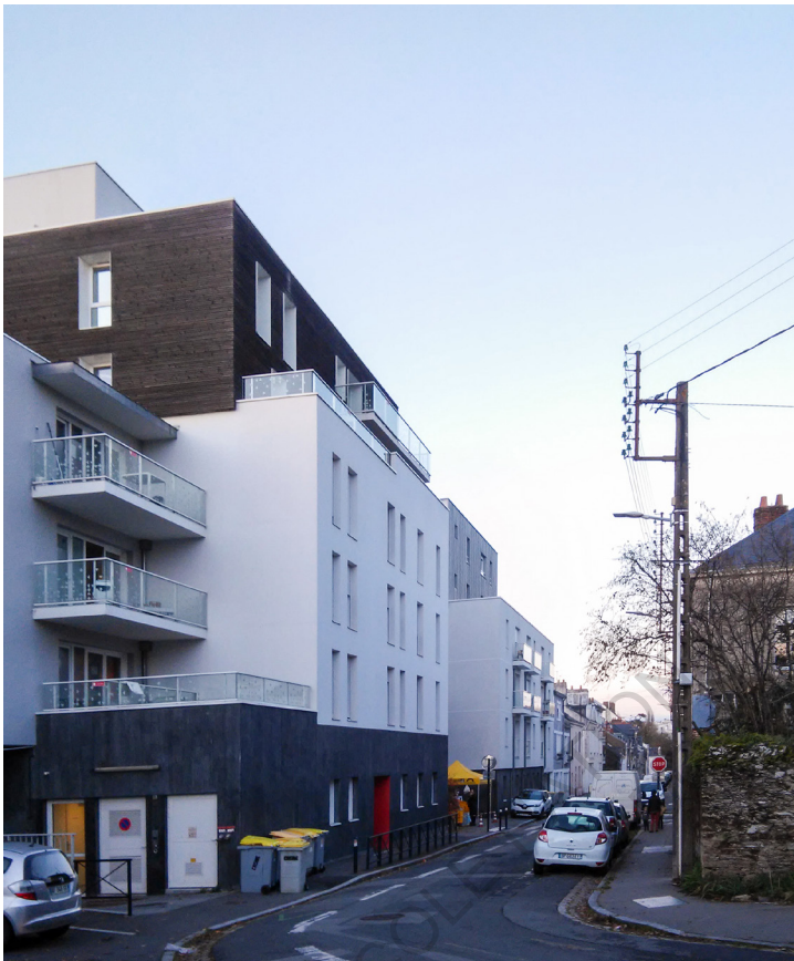
Fig. 55 L'imposant front bâti du « village du Bois Bouchaud » dans un quartier nantais
