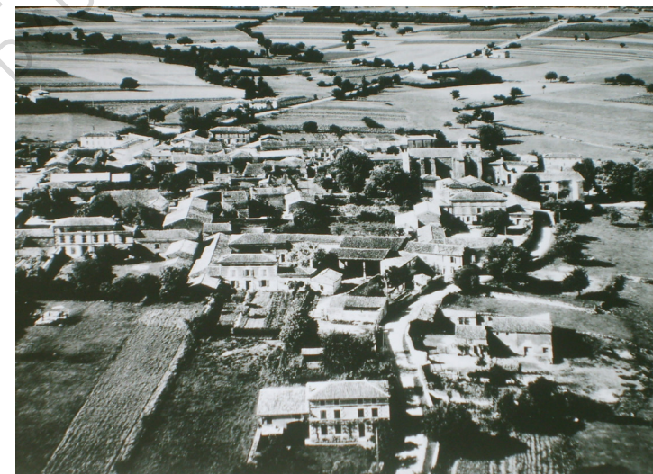
Fig. 3 Vue aérienne de la face Sud d'Echallat, avec la route départementale Hiersac-Rouillac passant à l'arrière-plan. Non datée, probablement milieu du XX ème siècle.
