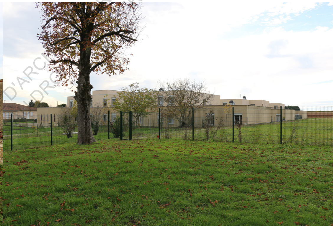
Fig. 49 L'EHPAD COS Les Fins Bois, vu depuis l'espace du 14 Juillet
