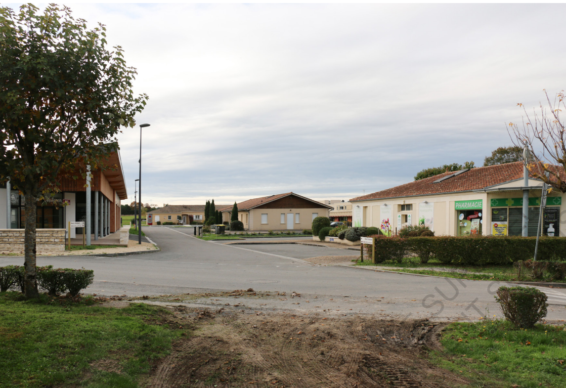
Fig. 44 Le pôle de santé de Mérignac. On aperçoit vaguement l'EHPAD COS Les Fins Bois, caché au fond, derrière la pharmacie (à droite)
