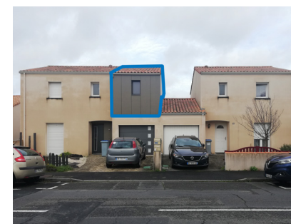
Surélévation, 83 rue de la Profondine
