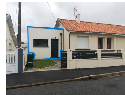
Extension, 17 rue des Robardières
