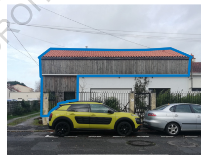
Surélévation, 21 rue des Saules
